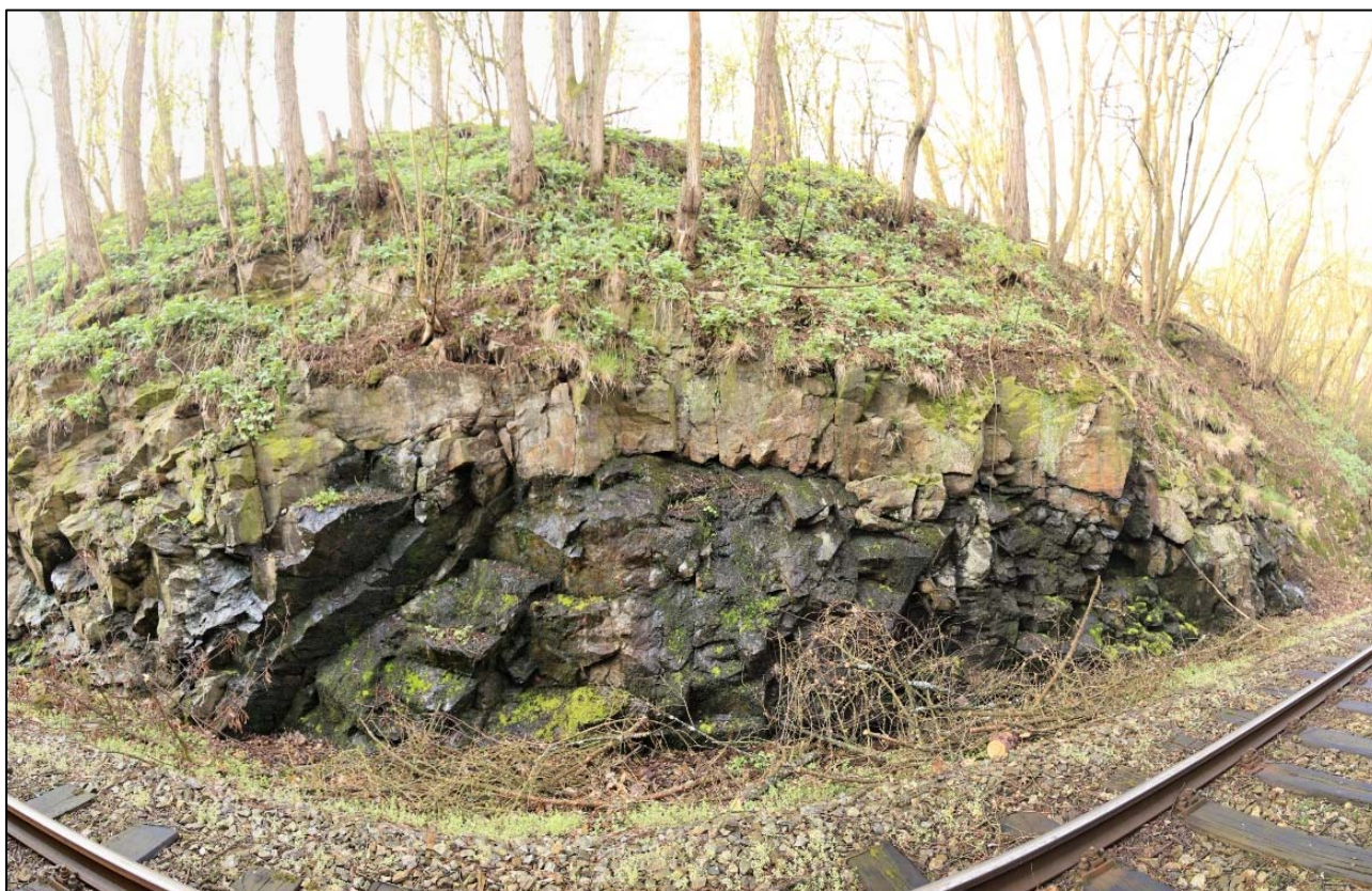
Obr. 12: panoramatický pohled na levostranný svah v km 4,380 – 4,395, Výrazný rozdíl stavu zvodnění masívu pod vodonosnou puklinou a také výrazně hustý porost stromů za hranou skalního svahu
