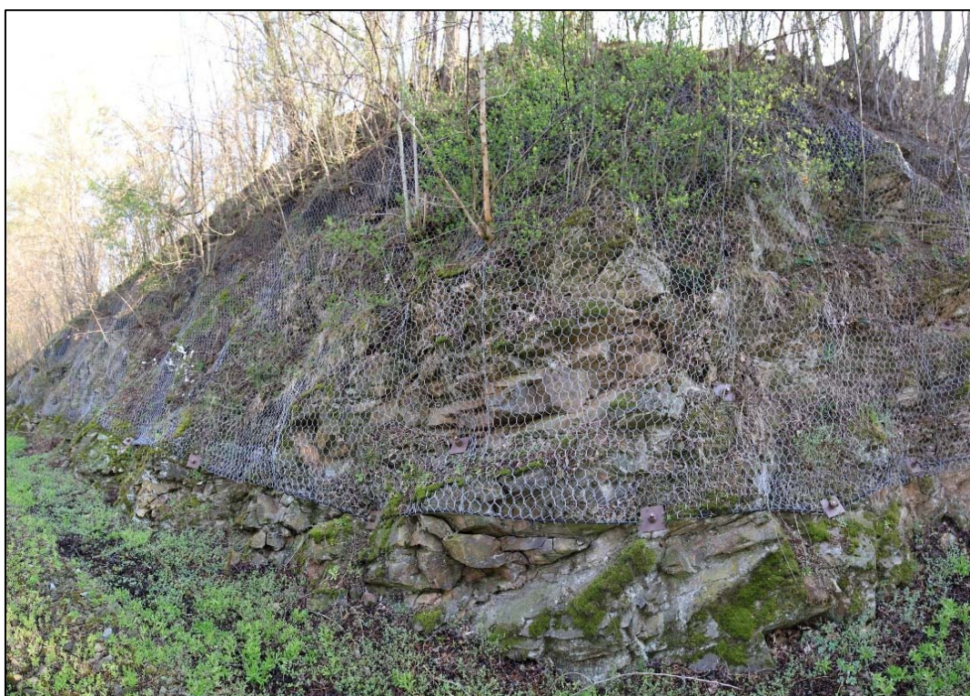
Obr. 31: panoramatický pohled na levostranný svah v km 12,350 – 12,370, se stávajícím zajištěním ocelovými sítěmi s okem 60x80 mm, degradace a rozpad masívu až do charakteru vyzdívky !
