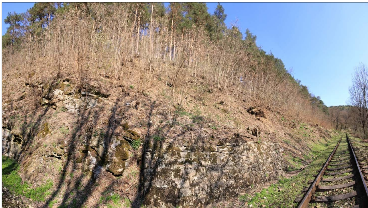
Obr. 156: panoramatický pohled na stávající zárubní zídku a její vazbu na poloskalní svahy v km 25,020 – 25,035
