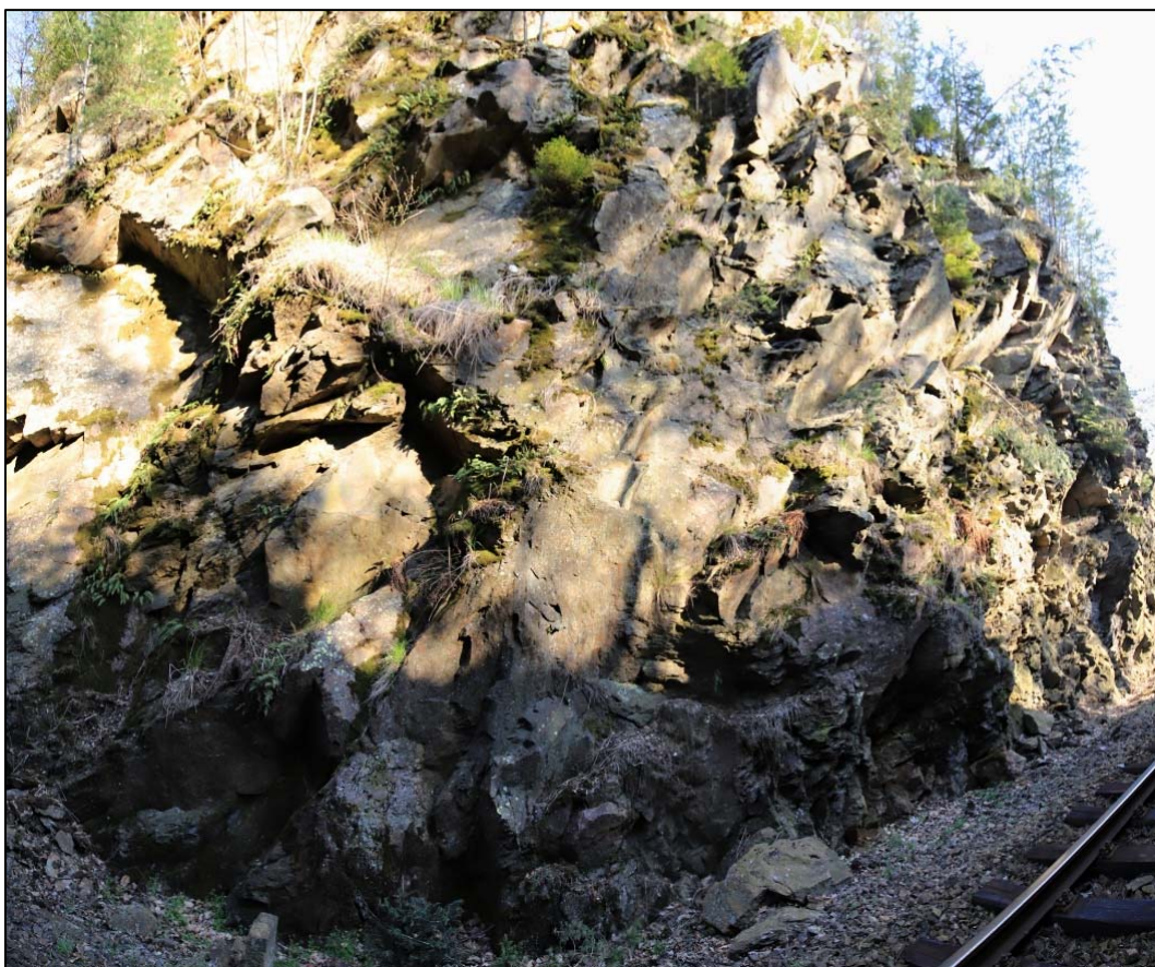
Obr. 187 a 188: panoramatické pohledy na levostranný skalní masív v km 28,890 – 28,910, výrazná členitost masívu s hustým vegetačním krytem v horních partiích svahu
