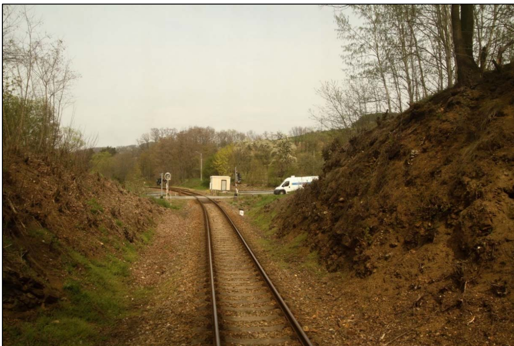
Obr. 41: Celkový pohled na stav zářezu v km 13,500 – 13,525, směr Strakonice, výrazná degradace masívu do charakteru zeminy
