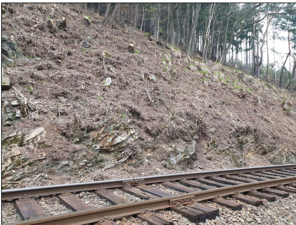
Obr. 244: degradace skalního svahu s pokryvem z vegetačních zbytků v km 31,960 – 31,980
