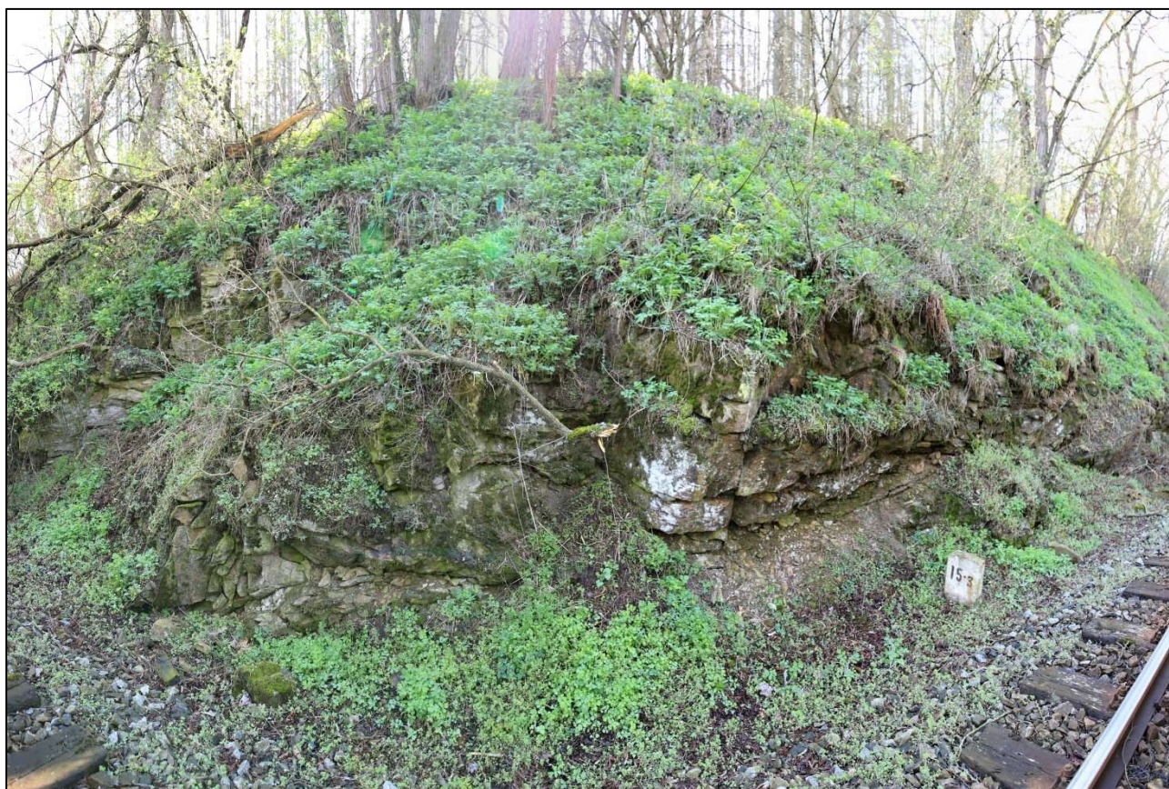
Obr. 49: panoramatický pohled na stav levostranného svahu v km 15,290 – 15,300, mrazové zvětvávání a rozpad na plochách poruch a foliace, hustý vegetační kryt svahu
