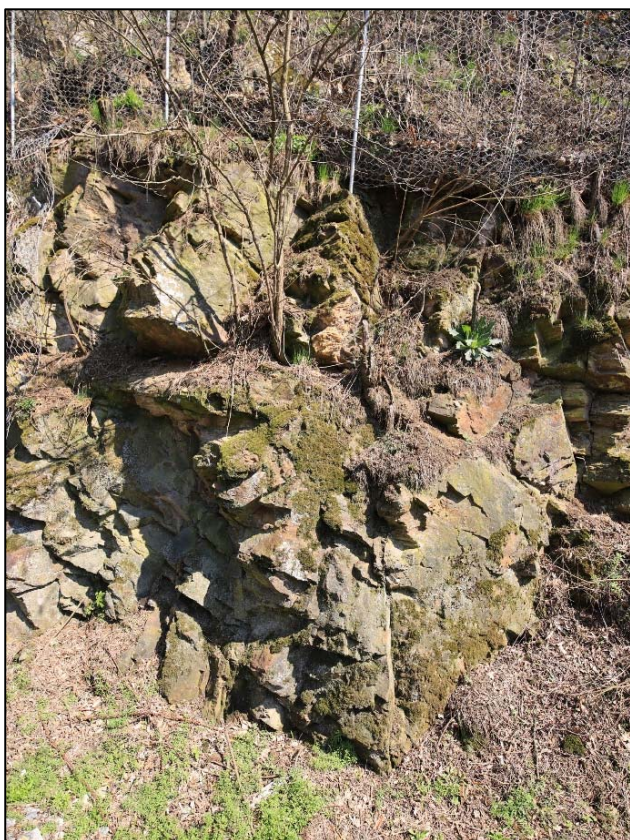
Obr. 96 a 97: detail stavu degradace skalního masívu v km 18,973 – 18,952, bloky jsou již zcela odloučeny od mateřské horniny, míra rozevření puklin 25 – 80 mm
