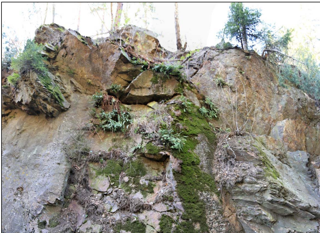
Obr. 185 a 186: pravostranná část zářezu v km 28,885 s výraznými převisy v horní partii a blokovým posunem ve výšce cca 4,5 m nad TK, systém ploch odlučnosti značně vymezuje stavbu uměle vytvořeného zářezu
