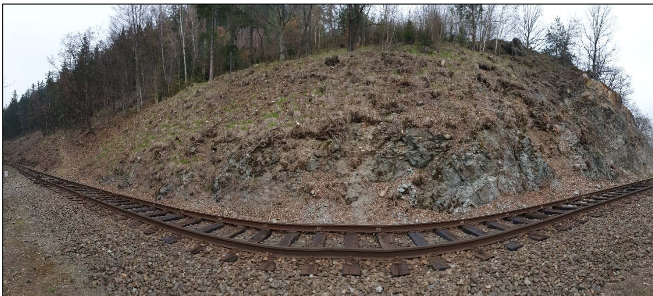
Obr. 249: panoramatický pohled na skalní svah v km 32,000 – 32,050 s plošnými projevy hloubkového zvětrání
