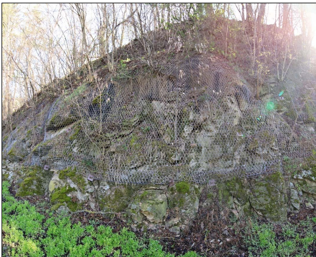
Obr. 30: panoramatický pohled na levostranný svah v km 12,335 – 12,350, se stávajícím zajištěním ocelovými sítěmi s okem 60x80 mm, horní partie hustě prorostlé náletem, výrazná degradace masívu pod sítěmi
