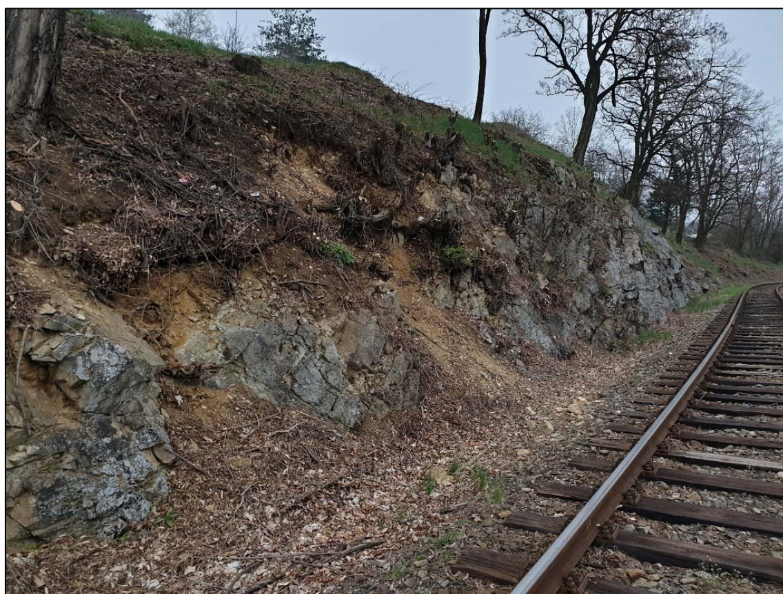
Obr. 256: detail stavu extrémního zvětrání skalního svahu v km 32,200
