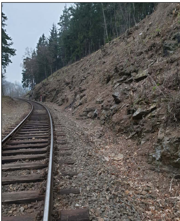
Obr. 242: pohled směr Strakonice z km 31,950 – 31,900, četný opad ze skalního svahu do zaneseného příkopu
