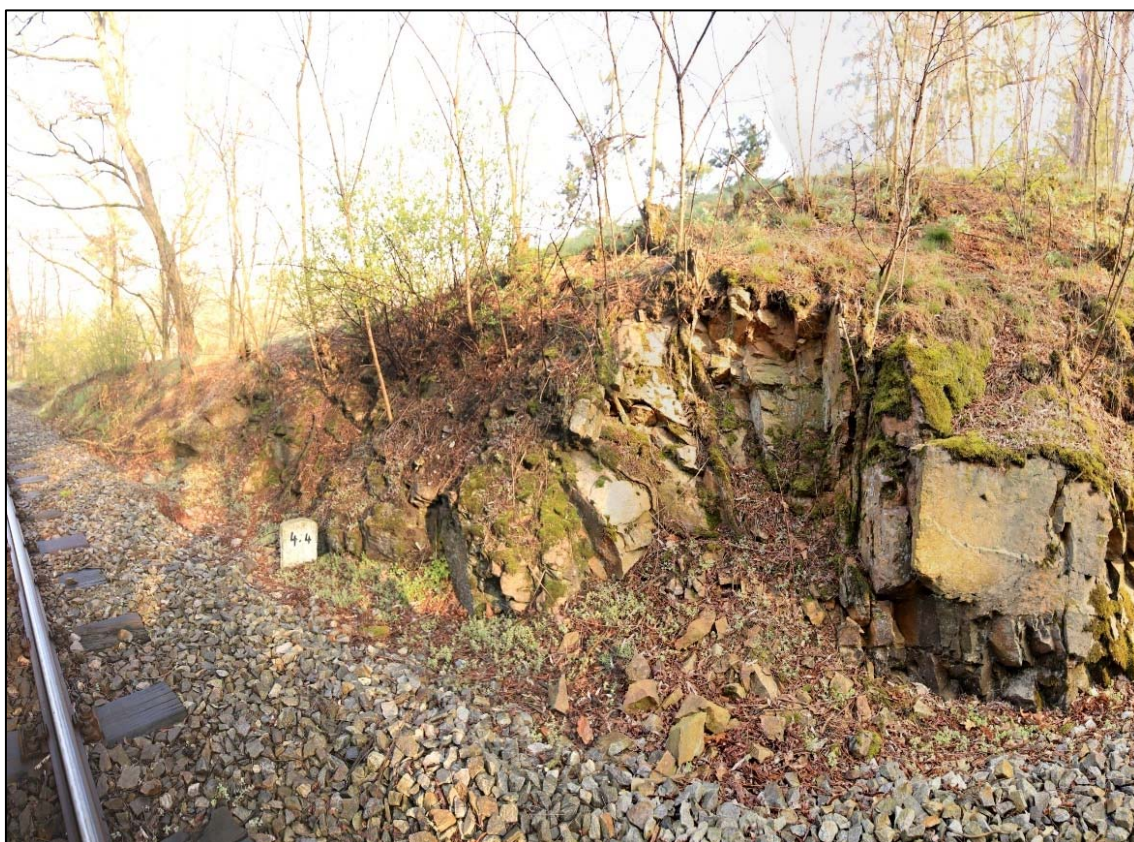
Obr. 22: panoramatický pohled na levostranný svah v km 4,395 – 4,405, Silná degradace a zvětrání masívu s opadem do příkopu
