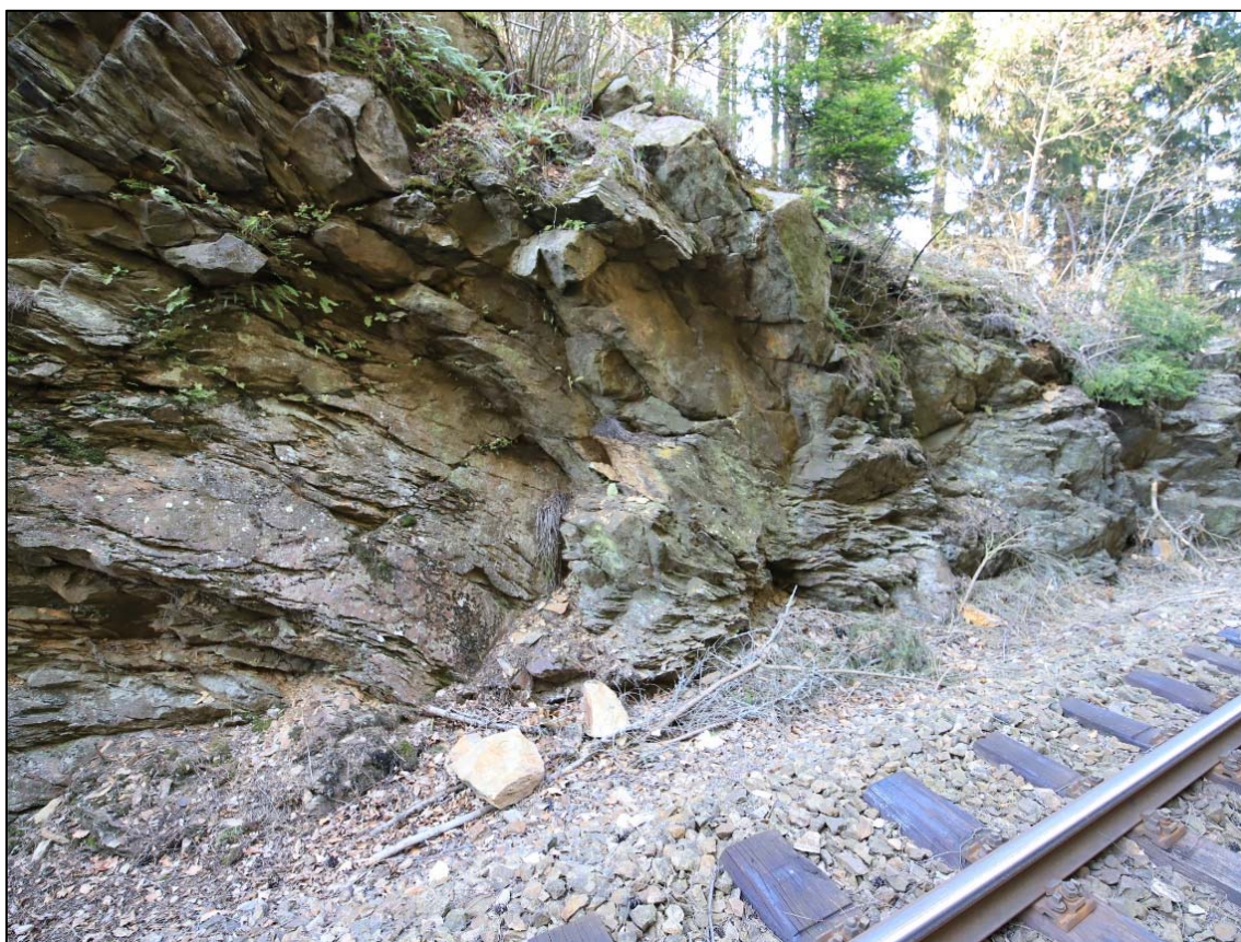
Obr. 179: příklad formování pravostranné části zářezu a jeho narušení zvětráním a opadu, km 28,860 – 28,870
