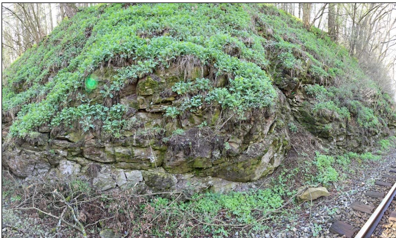
Obr. 50: panoramatický pohled na stav levostranného svahu v km 15,310 – 15,325, mrazové zvětvávání a rozpad na plochách poruch a foliace, hustý vegetační kryt svahu, vypadávání podél poruch a erozních rýh
