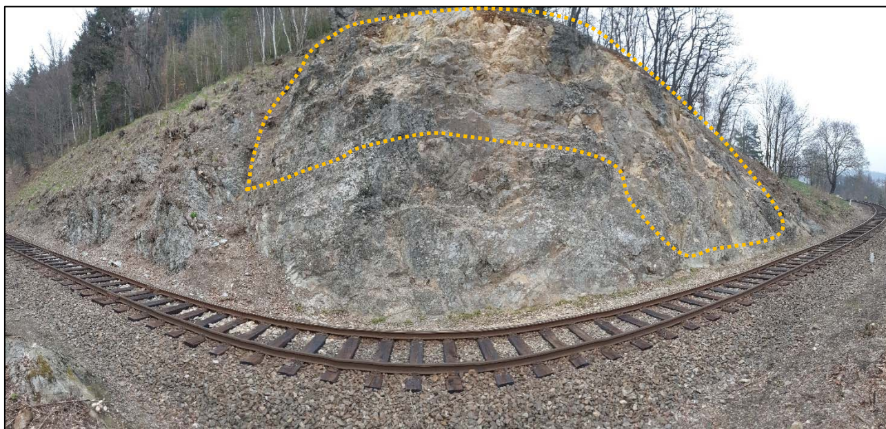
Obr. 250: panoramatický pohled na skalní svah v km 32,040 – 32,070, střední pasáž v km 32,059 – 32,072 není součástí této stavby, k zajištění dojde v rámci jiné stavební akce ve vyznačené oblasti
