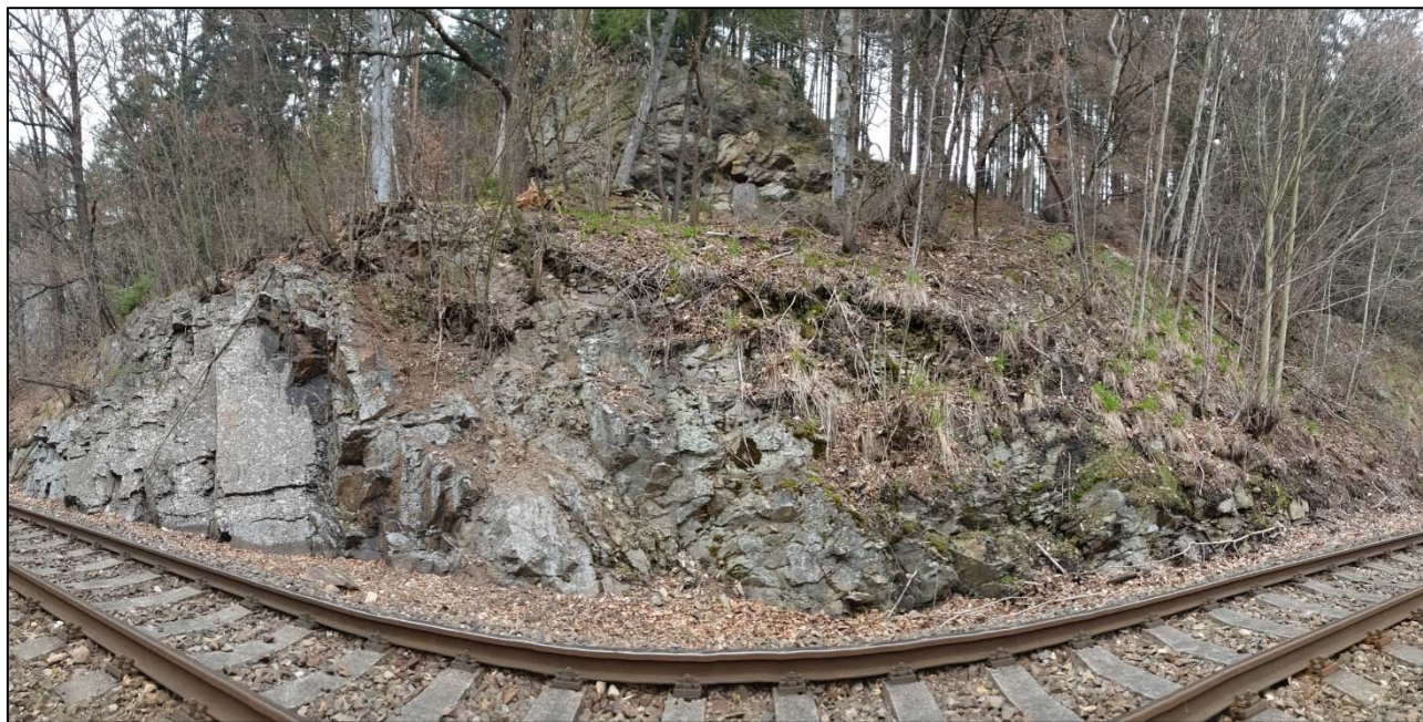
Obr. 225: panoramatický pohled na skalní odřez v km 31,370 – 31,410, v horní partii je skalní blokový výchoz, ze kterého dochází k opadům bloků po svahu, tento blok je mimo pozemky SŽDC
