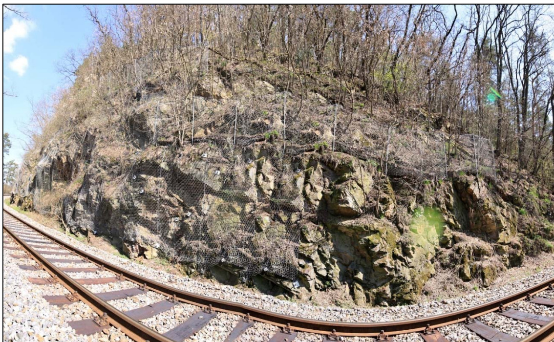
Obr. 95: panoramatický pohled na závěrečnou levostrannou část skalního svahu v km 18,930 – 18,955 se stávajícím zajištěním z roku 2005/2006 – ocelové sítě s křížnými lany a lehký ochranný plot za horní linií sítí, pod ochranným plotem se již silně degradovaný a odloučený masív
