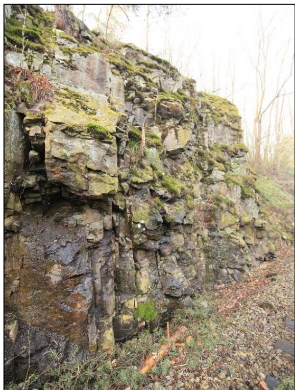
Obr. 03 a 04: tvar a míra porušení masívu v km 4, 280 – 4,295, stav podélného příkopu, levá strana
