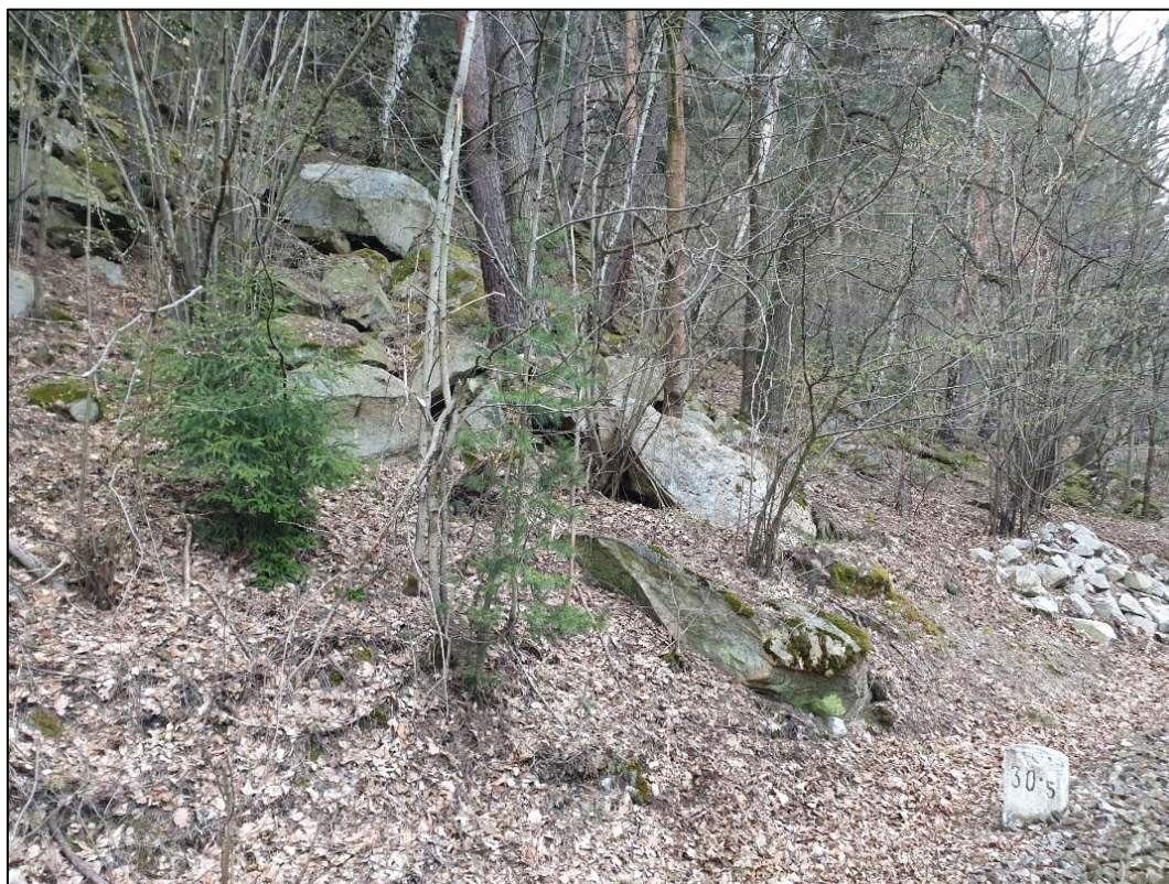
Obr. 205: stav paty svahu v km 30,500, množství velkých bloků je z historického vývoje skalního svahu a výstavby trati, v pozadí uložené kameny jsou pro účely rekonstrukce propustku v km 30,514
