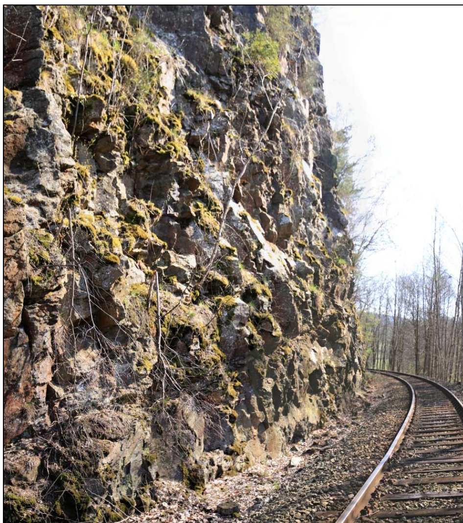
Obr. 164: pohled na strmou skalní stěnu v km 26,190 – 26,200, četné lokální převisy s opadem do prostoru příkopu
