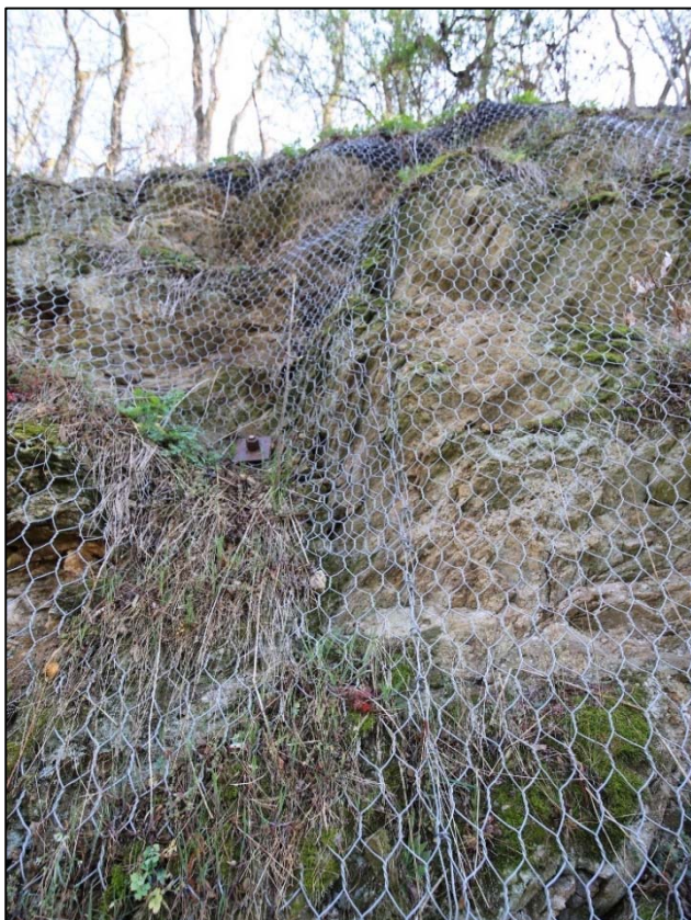
Obr. 36 a 37: detail degradace masívu a namáhání sítě po výšce svahu, kapacita sítě je z 90% vyčerpána
