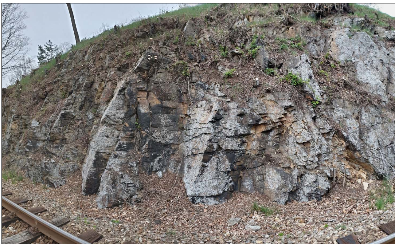
Obr. 259: panoramatický pohled na degradaci a míru rozevření puklin masívu v km 32,200 – 32,210, rozevření puklin 10 – 60 mm
