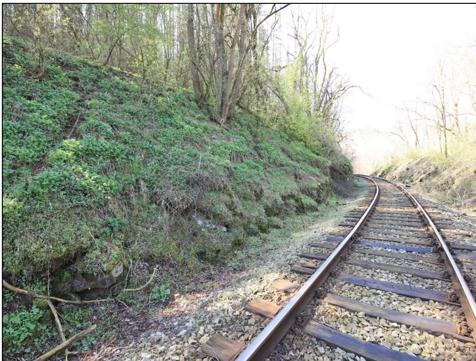
Obr. 46: hlavní pohled na levostrannou část zářezu v km 15,260 – 15,290, s velmi hustým vegetačním krytem svahu, patrný blokový rozpad zvětralého masívu ve spodních partiích
