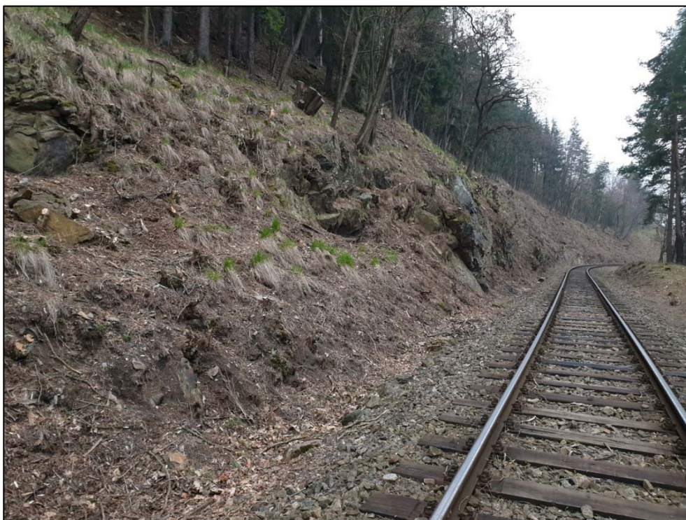
Obr. 233: pohled na skalní svah po odstranění vegetace v km 31,850 – 31,880, lokální ponechané stromy dále narušují skalní svah, samostatné výchozy jsou silně zvětralé
