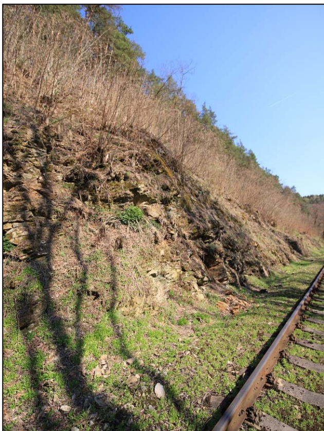
Obr. 151 a 152: detail stavu narušení a rozpadu masívu v km 24,990 – 24,995
