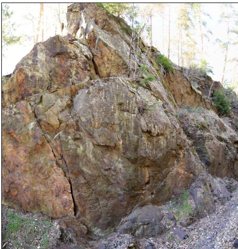
Obr. 192: závěrečná pasáž pravostranného masívu svahu v km 28,915 – 28,920, viditelné pukliny jsou způsobeny pákovým efektem vzrostlé borovice a dalším rozvojem postupné degradace masívu a navazující morfologii svahu k řece za hranou zářezu
