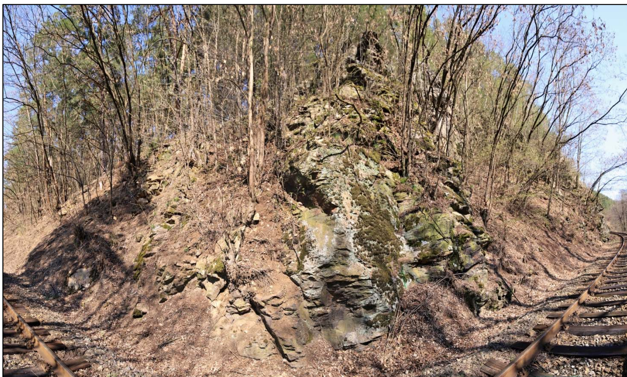
Obr. 128: panoramatický pohled na rizikový skalní masív v km 24,735 – 24,750, svah hustě porostlý a narušený náletovou vegetací a zvětráním ve zlomových strukturách
