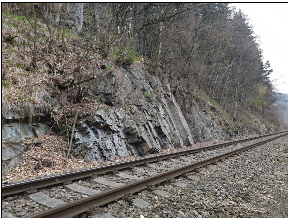
Obr. 221: celkový pohled na skalní odřez v km 31,370 – 31,410, horní hrana narušena náletem a výrazná bloková odlučnost
