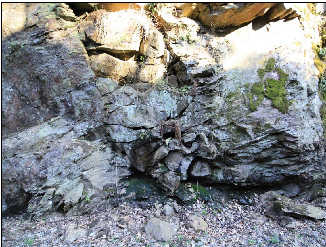
Obr. 184: detail poruchové zóny v km 28,885, vydatné výrony vody z poruchové zóny přímo v patě svahu
