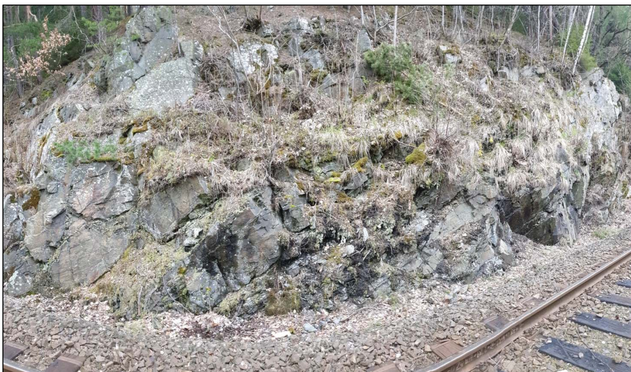
Obr. 210: panoramatický pohled na skalní defilé a jeho míru degradace a rozpadu v km 30,925 – 30,940
