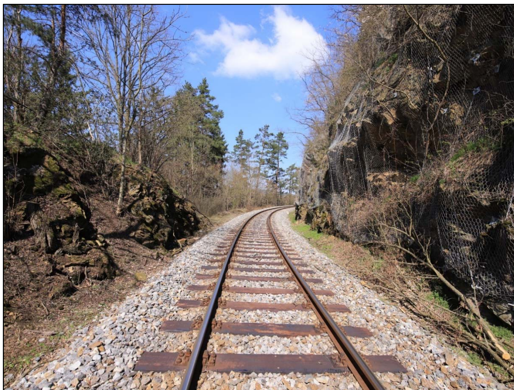
Obr. 94: pohled na zářez v km 18,900 - 18,945 směr Strakonice, členitost masívu a povaha podélného příkopu
