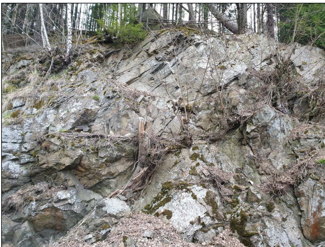
Obr. 214 a 215: detailní pohled na blokovou odlučnost a extrémní narušení masívu náletem v km 30,945 – 30,955, míra rozevření puklin 5 – 65 mm
