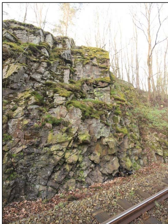
Obr. 03 a 04: tvar a míra porušení masívu v km 4, 280 – 4,295, stav podélného příkopu, levá strana
