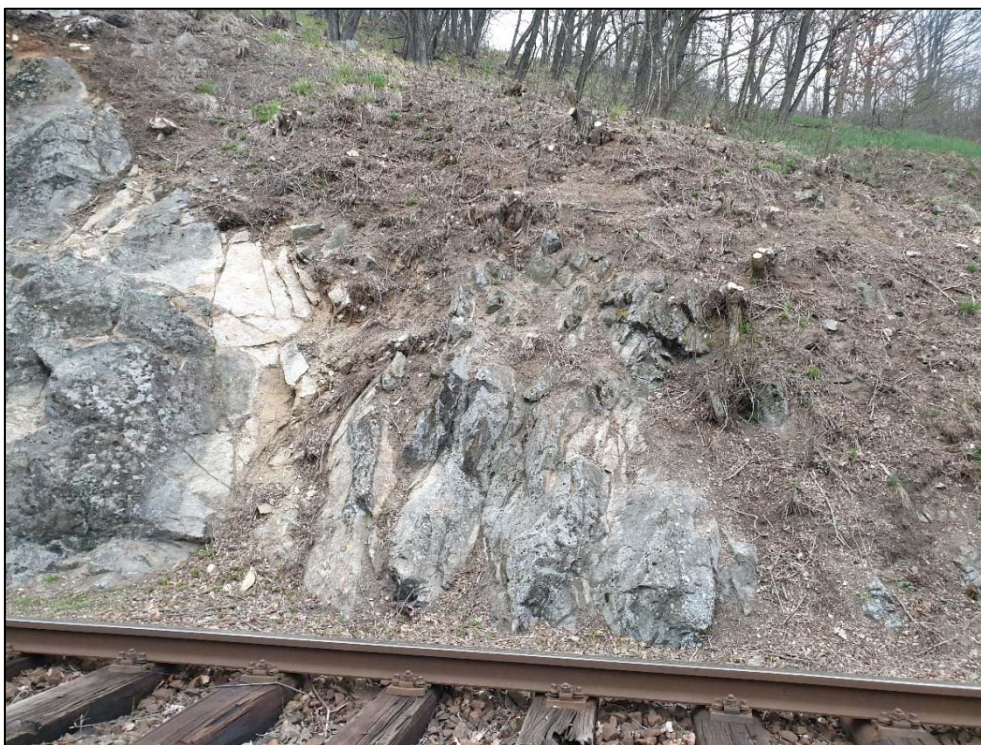
Obr. 251: pohled na degradaci masívu v km 32,075
