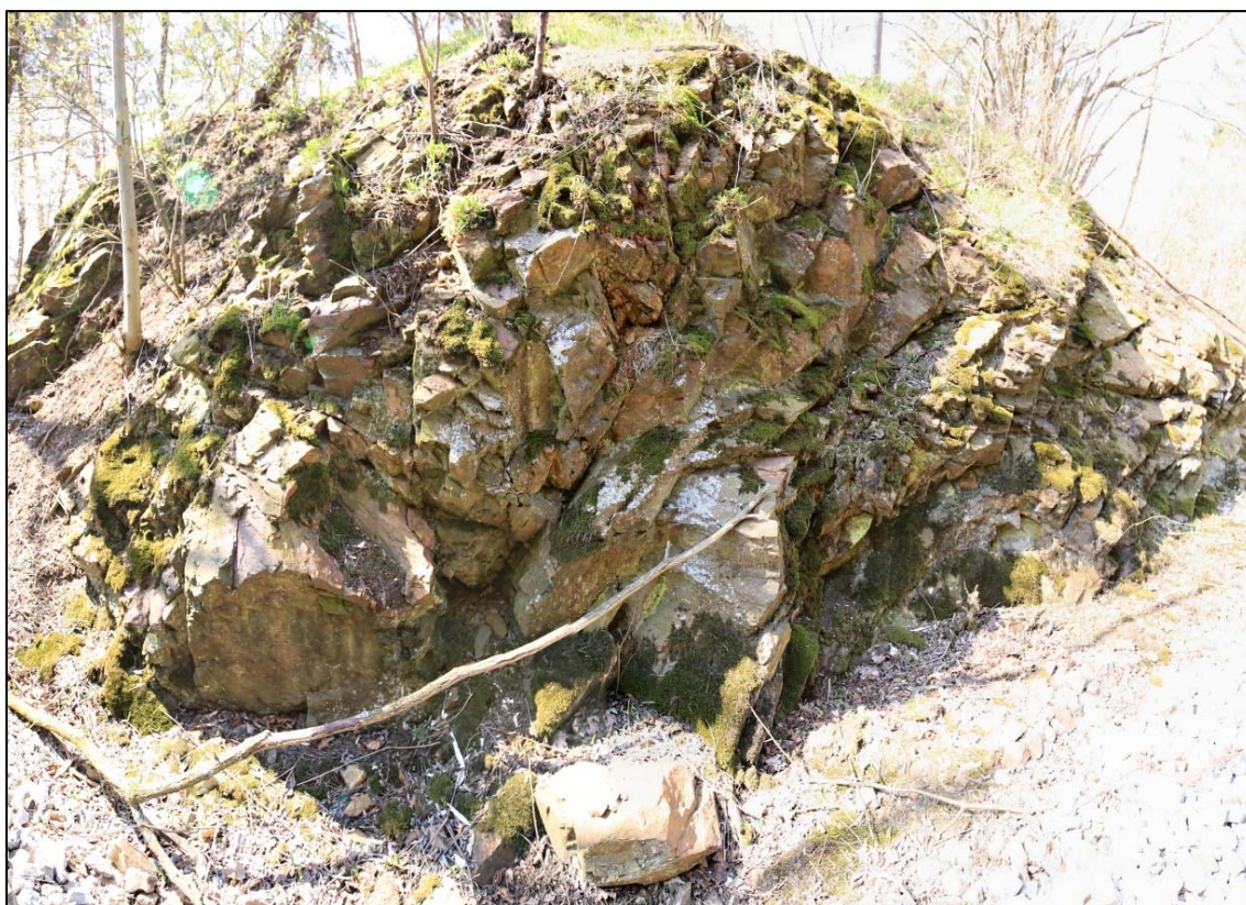
Obr. 89: celkový pohled na stav pravostranné části zářezu, blokový rozpad silné rozevření puklinového systému
