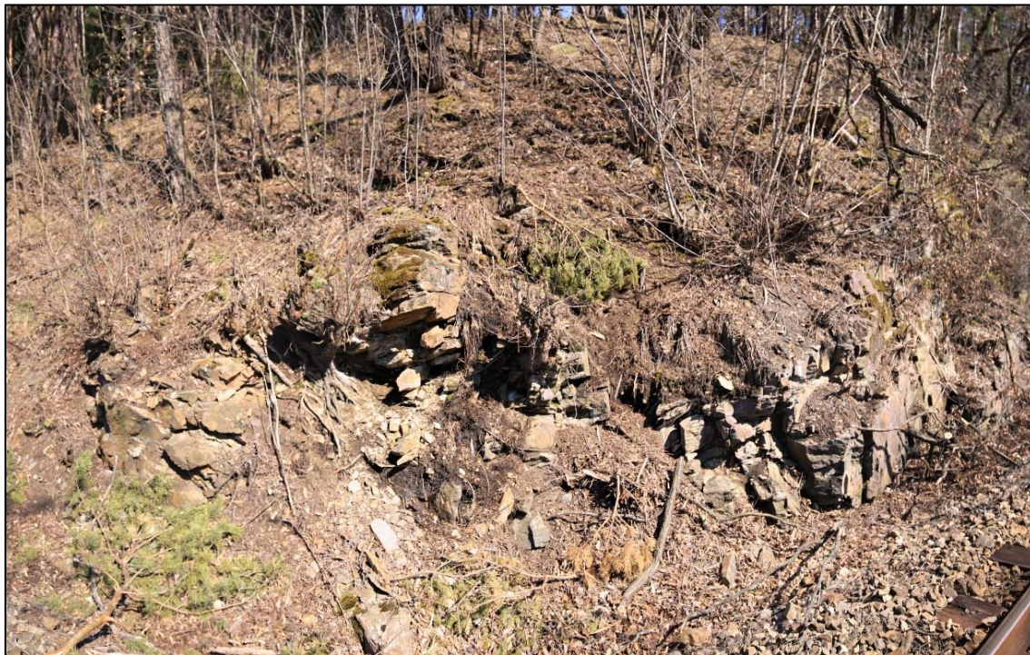
Obr. 122: detail degradace a rozpadu skalního výchozu levostranného svahu v km 24,652 – 24,660,
