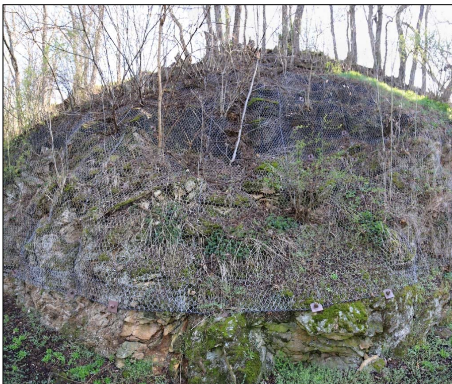
Obr. 32: panoramatický pohled na levostranný svah v km 12,350 – 12,370, Horní partie sítě položeny protierozní matrací, hustě prorostlé vegetací, rozpad skalního masívu
