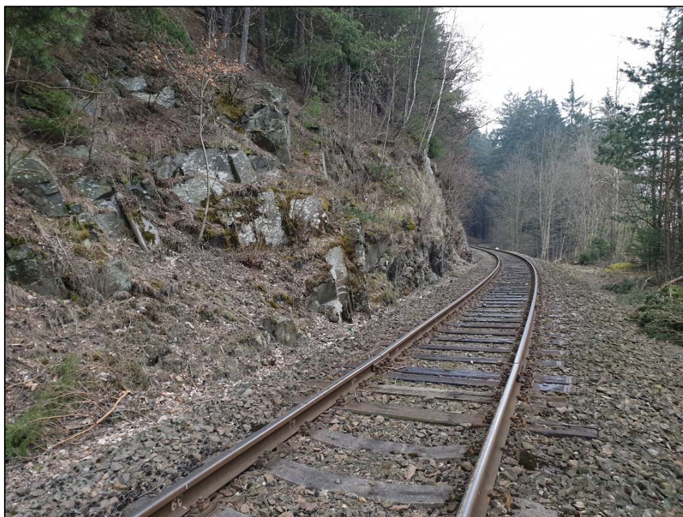
Obr. 208: celkový pohled na stavbu skalního svahu v km 30,920 – 30,960 vlevo, hustý porost náletové vegetace na horní hraně svahu
