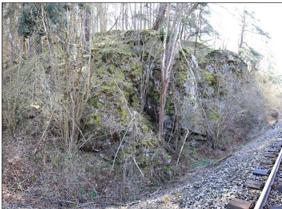
Obr. 58: panoramatický pohled na levostranný svah v km 15,405 – 15,430, skalní masív sice neohrožuje provoz, nutné však odstranění vegetace a pročištění příkopu
