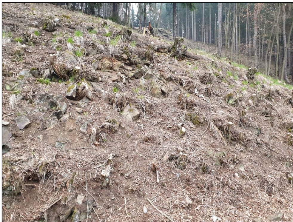
Obr. 230 a 231: poloskalní svah v km 31,790 – 31,800 po odstranění náletové vegetace a lokálními výchozy zvětralého skalního podkladu
