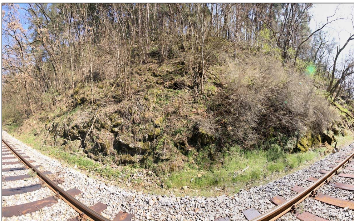
Obr. 115: panoramatický pohled na extrémně narušený masív v km 19,360 – 19,380, oblast se skalním sunutím a velmi hustým vegetačním porostem svahu, část stromů je i riziková pro provoz na trati
