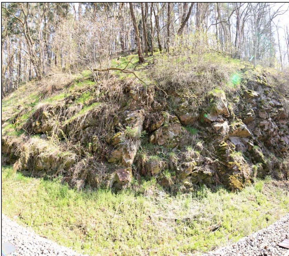
Obr. 85: degradace levostranného svahu v km 18,890 – 18,900
