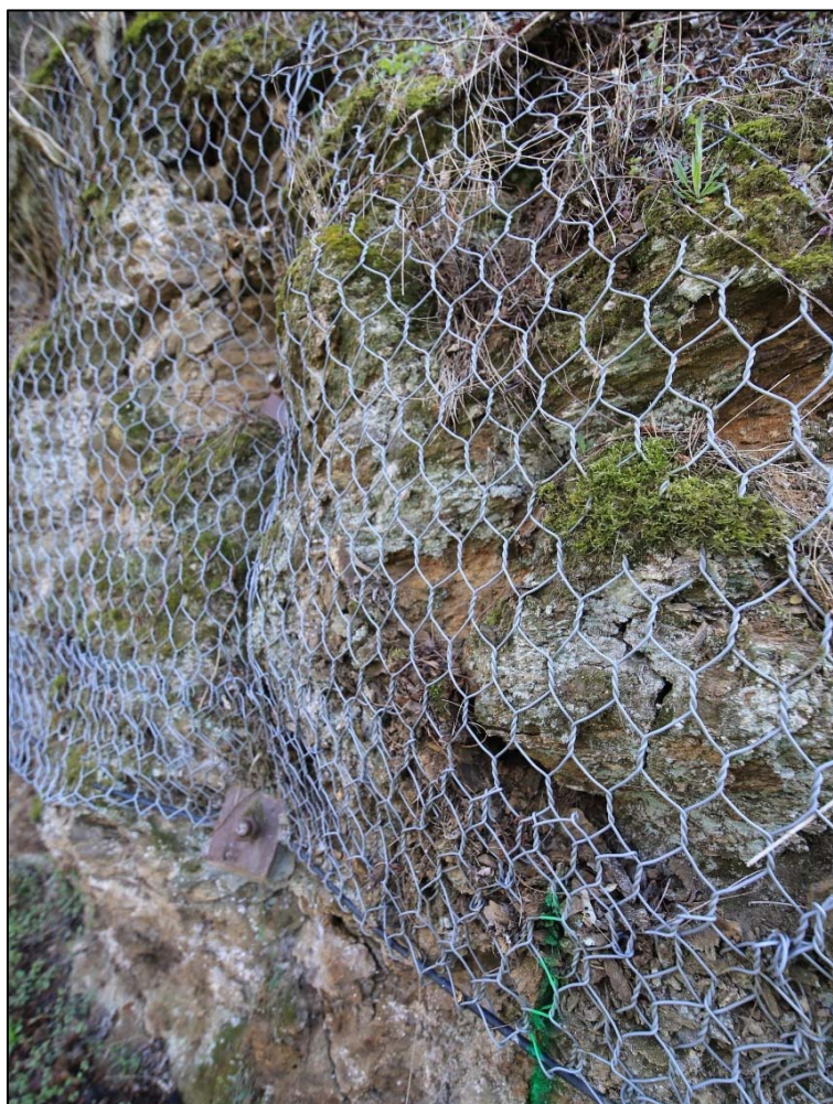
Obr. 34: detail stavu degradace masívu pod sítěmi, rozpad na úlomky menší jak 3 cm Souvislé zatížení sítí uvolnou masou zvětralého materiálu,
