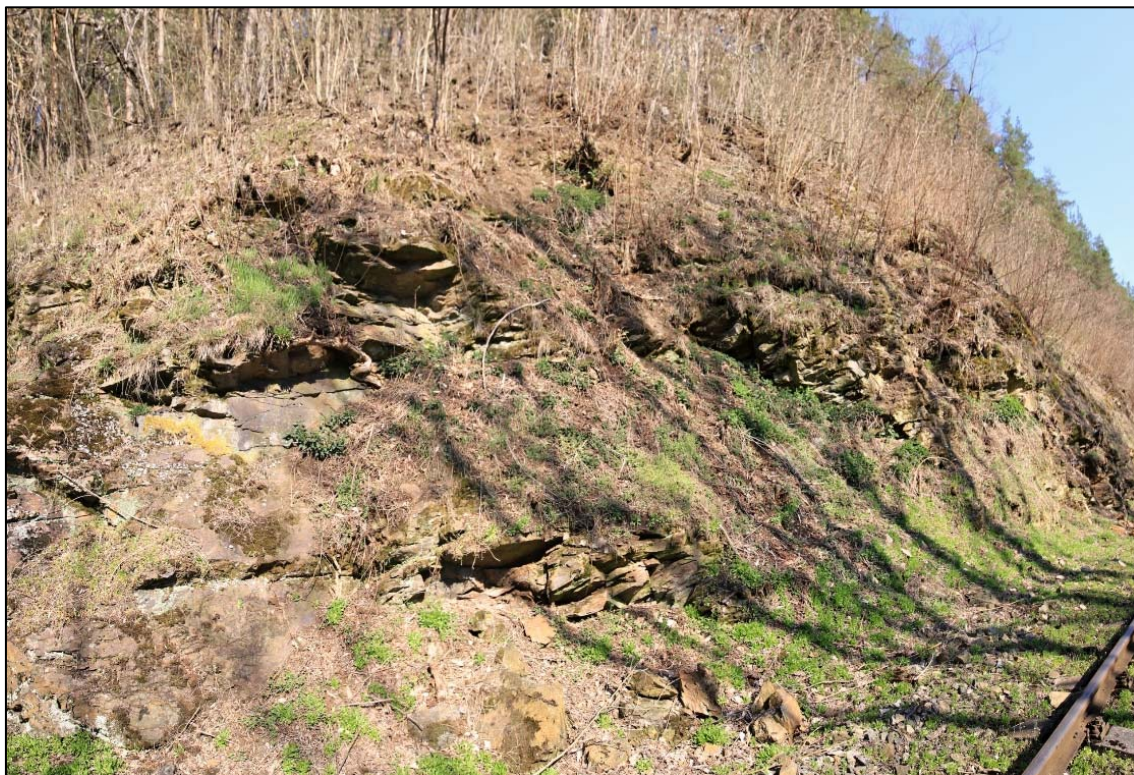
Obr. 150: panoramatický pohled na skalní výchozy s blokovým rozpadem v km 24,980 – 25,000
