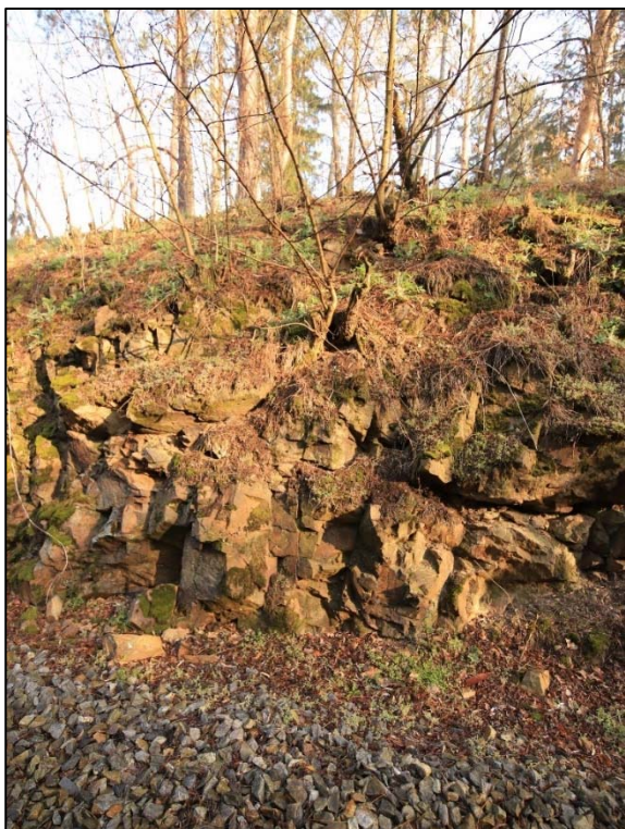
Obr. 19 a 20: detail degradace a rozpadu masívu pravostranného svahu v km 4,380 – 4,400
