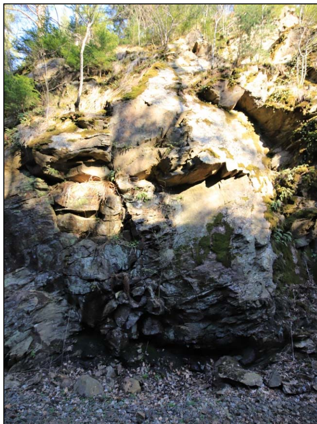
Obr. 182 a 183: levostranné velmi narušené pasáže s blokovým rozpadem a posuny masivu, horní partie svahu silně narušeny náletovou vegetací, km 28,882 – 28,888
