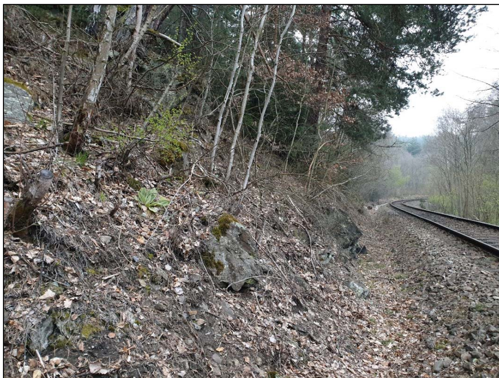
Obr. 202: pohled na levostrannou patu svahu a stav podélného příkopu, levostranný svah s hustým porostem náletovou vegetací
