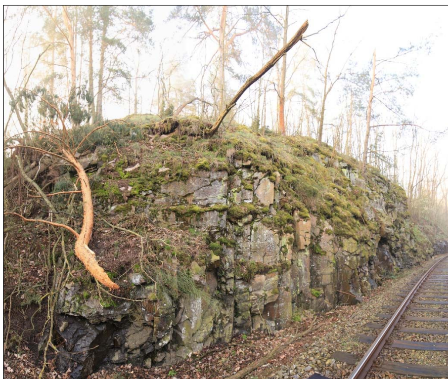
Obr. 02: pohled levostrannou skalní stěnu v km 4,275- 4,300, viditelné výrony vody ze spodních partií
