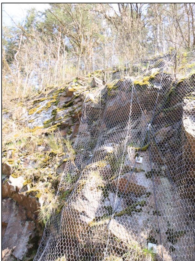
Obr. 87 a 88: detail stavu ochranných prvků – ocelové sítě s okem 60x80 mm s křížnými lany v silně zvětralých polohách v km 18,916 a 18,918, rizikové místo bylo problematické již během realizace stávacího zajištění v roce 2005 / 2006
