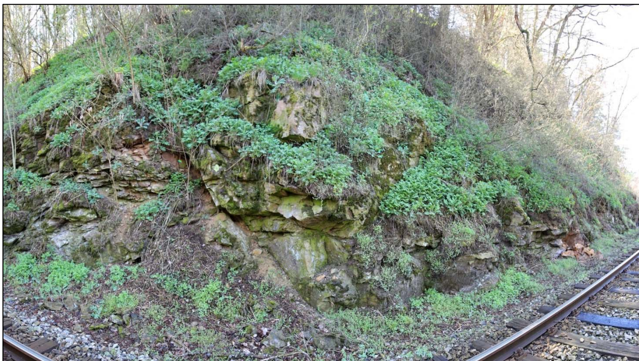
Obr. 52: panoramatický pohled na stav levostranného svahu v km 15,320 – 15,345, mrazové zvětvávání a rozpad Znatelný silný opad částí masívu a blokové opadávání zvětralých částí, většina bloků je již zcela oddělena od masívu, pukliny 5 – 50 mm, vyplněny hlinito písčitou frakcí, silně mrazové zvětvávání
