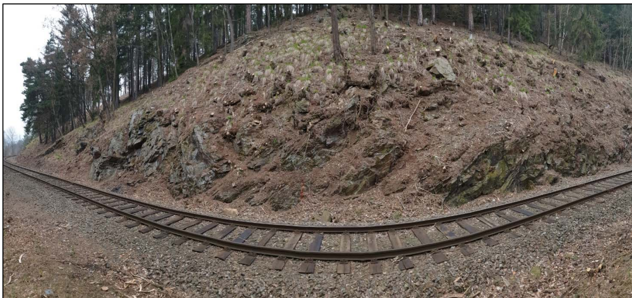
Obr. 238: panoramatický pohled na skalní svah v úseku km 31,820 – 31,900, viditelná stavba a různorodost stavu zvětrání s lokálními vzrostlými stromy
