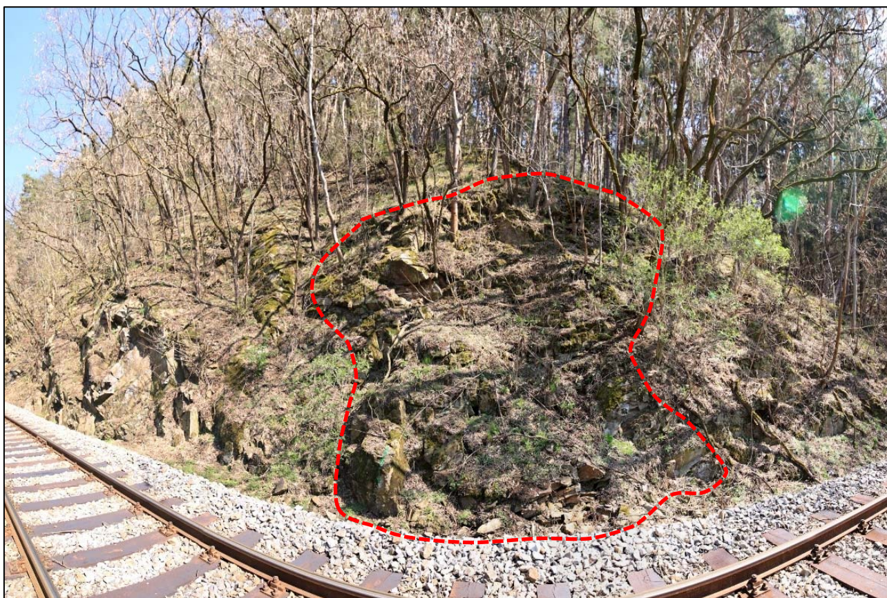
Obr. 111: panoramatický pohled oblast skalního ploužení – pomalého sunutí bloků podél predisponovaných ploch odlučnosti, vyznačená oblast se zřetelnou odtrhovou linií s nasunutím až do podélného příkopu, velmi hustý porost svahu náletovou vegetací
