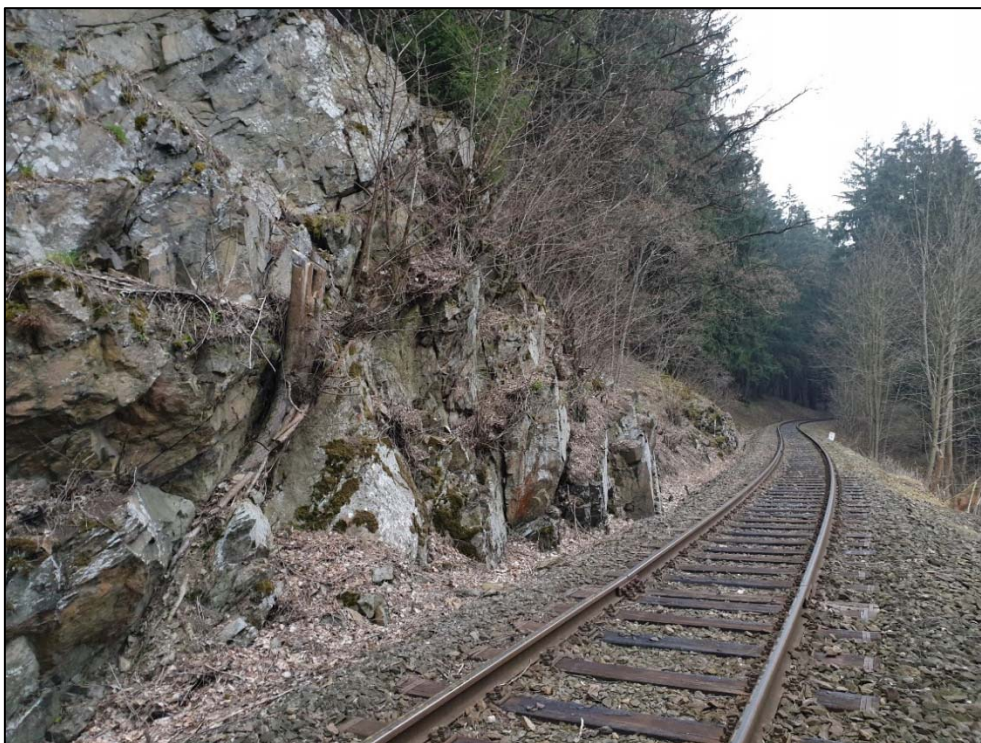
Obr. 212: celkový pohled na blokovou odlučnost a extrémní narušení masívu náletem v km 30,945 – 30,955
