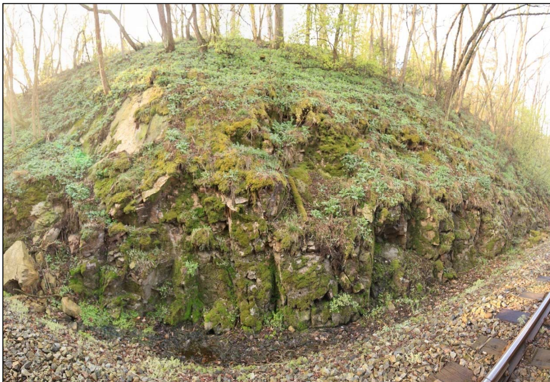
Obr. 21: panoramatický pohled na levostranný svah v km 4,420 – 4,435, Silná degradace a zvětrání masívu, opad bloků a silné zvodnění v příkopu
