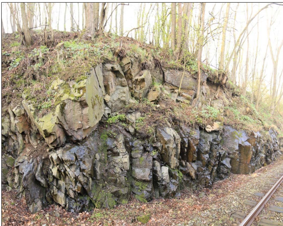
Obr. 07: stavba a degradace masívu v km 4,310 – 4,340, zcela zřetelná vodonosná puklina masívu a vliv vegetace na skalní masív
