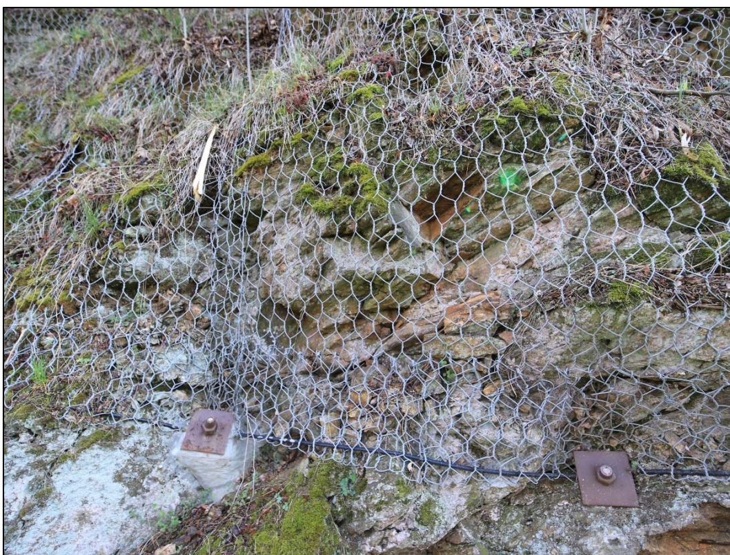
Obr. 39: rozpad masívu pod sítěmi, síť plní svůj účel, jejich kapacita je však již vyčerpána, kotvení prvky mají délku 1,0 a 1,25 m, míra zvětrání masívu je více jak 1,5 m
