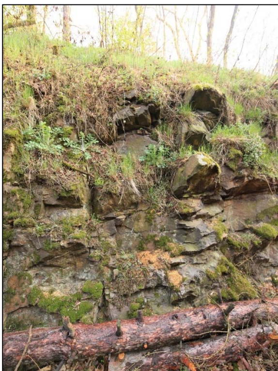
Obr. 13 a 14: detail silně degradovaných místa pravostranného svahu zářezu v km 4,340 – 4,350
