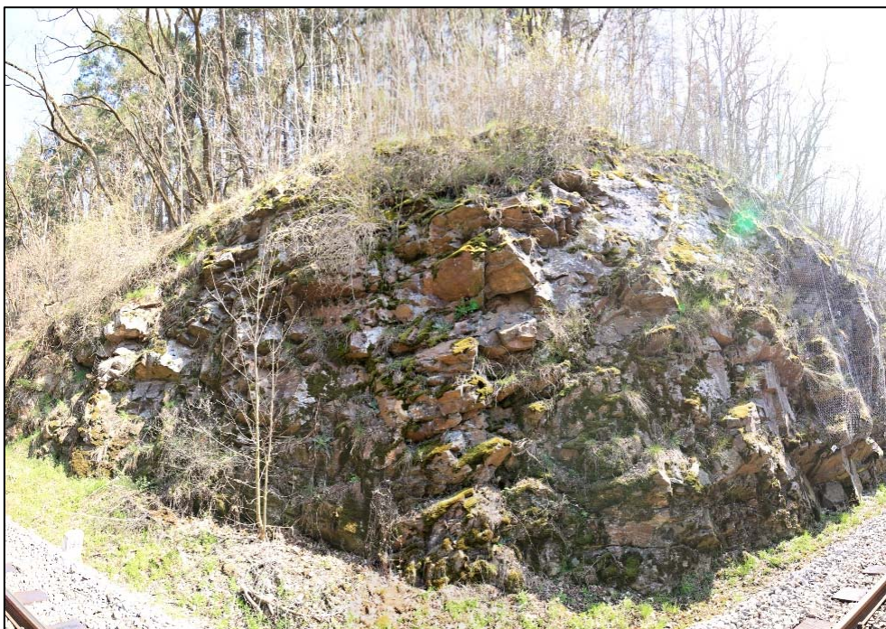
Obr. 86: stav zvětrání a členitost nezajištěného svahu v km 18,900 – 18,915
