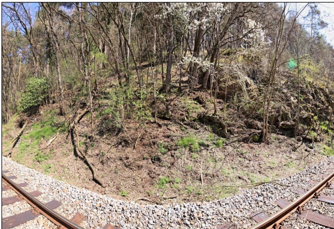
Obr. 101: postupný výchoz skalního masívu v km 19,150 – 19,170 s polohou mnoha rizikových vzrostlých stromů a zcela zaneseným příkopem
