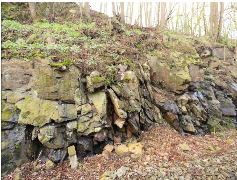
Obr. 06: detail míry zvětrání a narušení levostranného masívu v km 4,300 a vodonosné pukliny masívu
