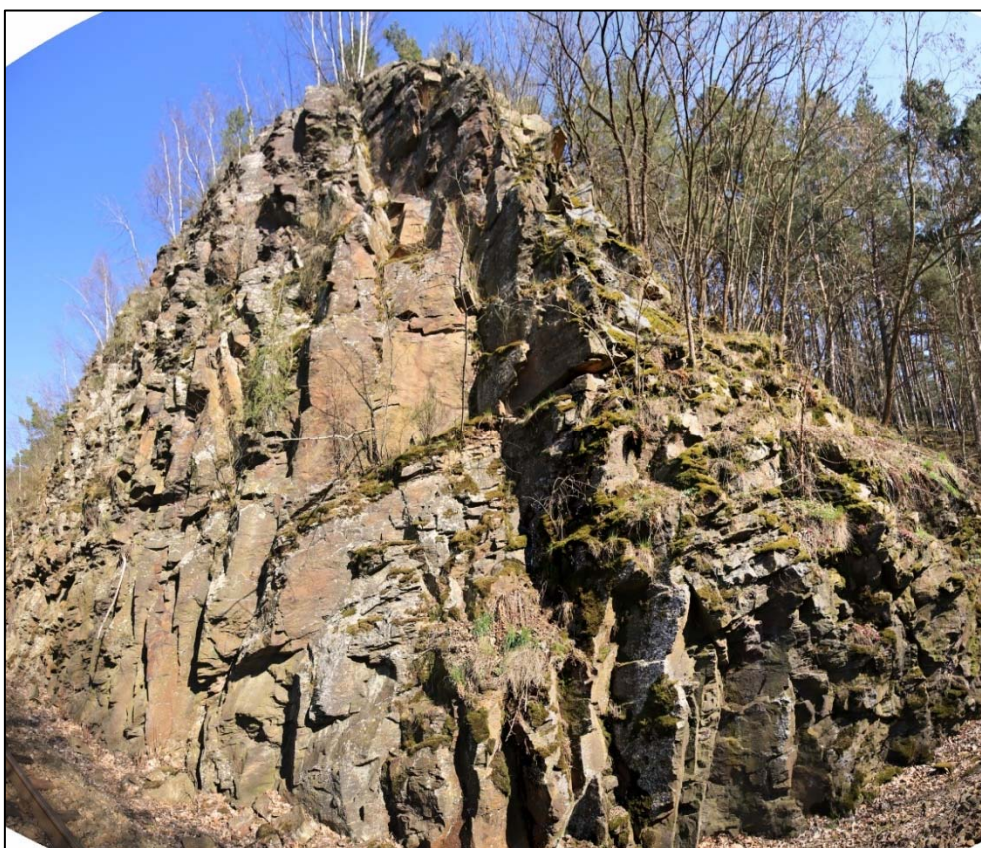
Obr. 172: panoramatický pohled na měnící se morfologii stěny v km 26,220 – 26,230, znatelné znaky porušení masívu podél predisponovaných ploch odlučnosti
