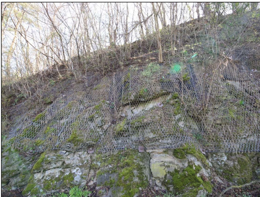
Obr. 29: detail stavu svahu se stávajícím zajištěním ocelovými sítěmi s okem 60x80 mm, horní partie hustě prorostlé náletem, výrazná degradace masívu pod sítěmi
