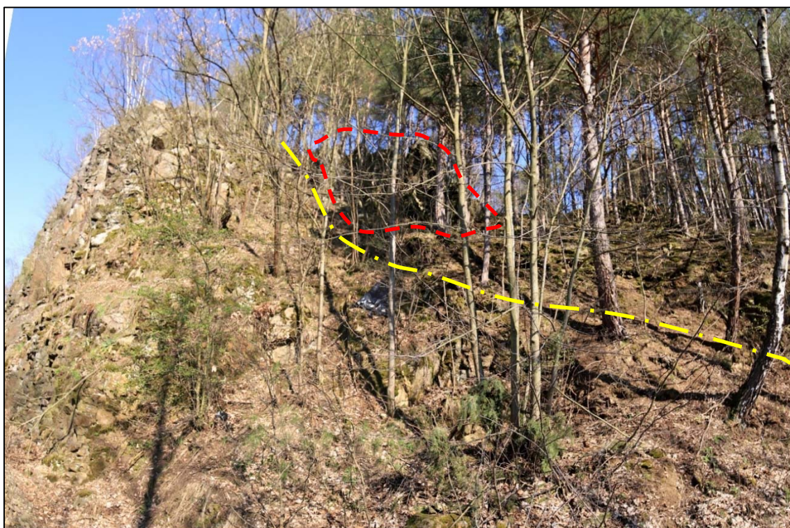
Obr. 173: pohled na závěrečné pasáže skalního masívu v km 26,230 – 26,250 vlevo, žlutou linií vyznačena pozemková hranice, červeně vyznačená oblast vymezuje rizikový skalní masív s výraznou blokovou odlučností s vysokým rizikem pro provoz na trati
