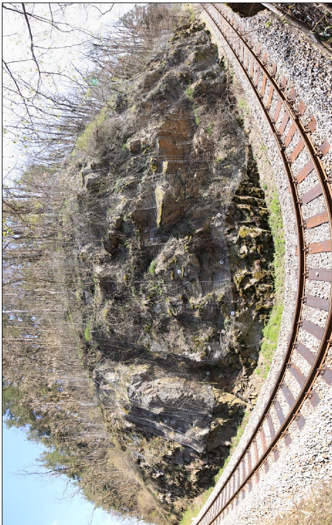
Obr. 90: panoramatický pohled na hlavní část skalního svahu v km 18,900 – 18,960 se stávajícím zajištěním z roku 2005/2006 – ocelové sítě s křížnými lany a lehký ochranný plot za horní linií sítí, hustota porostu náletovou vegetací
