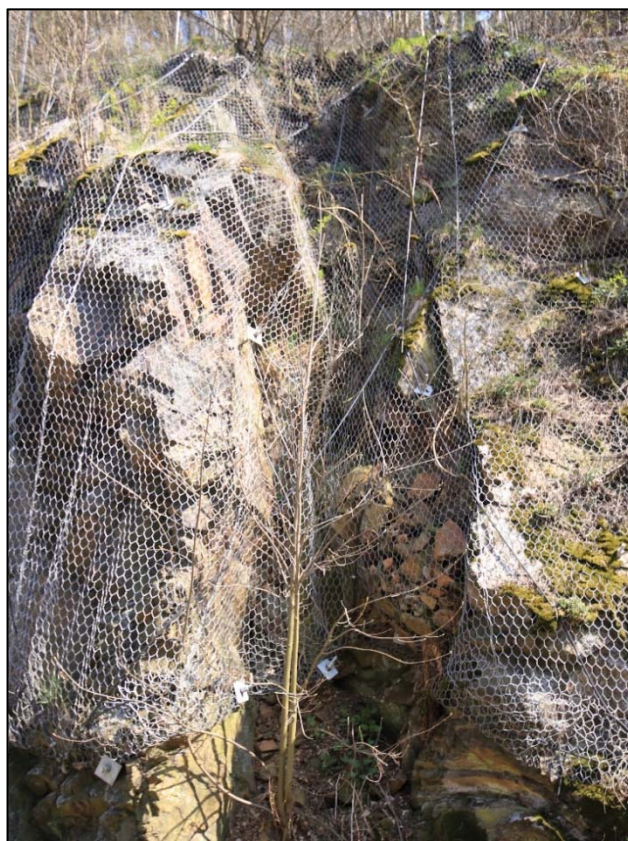
Obr. 87 a 88: detail stavu ochranných prvků – ocelové sítě s okem 60x80 mm s křížnými lany v silně zvětralých polohách v km 18,916 a 18,918, rizikové místo bylo problematické již během realizace stávacího zajištění v roce 2005 / 2006
