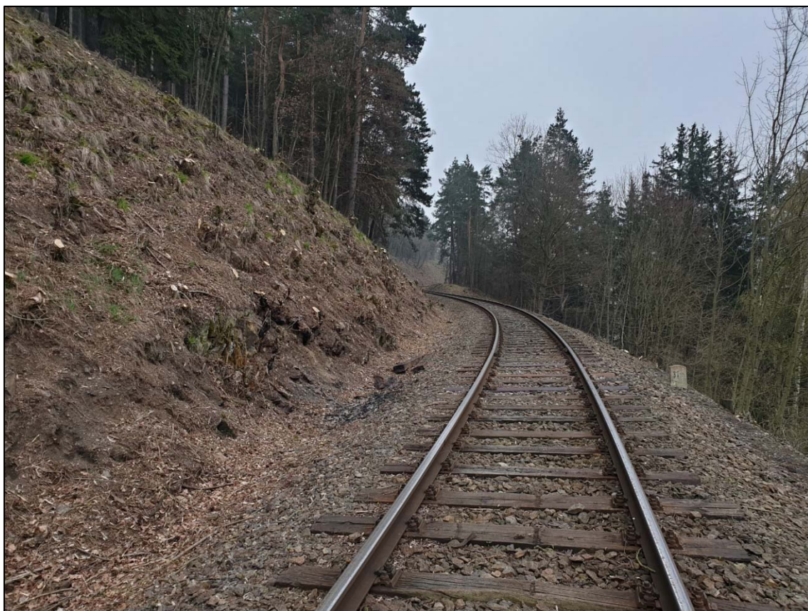
Obr. 230 a 231: poloskalní svah v km 31,790 – 31,800 po odstranění náletové vegetace a lokálními výchozy zvětralého skalního podkladu
