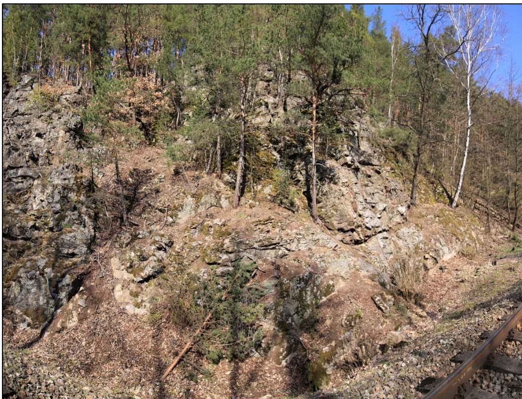
Obr. 142: panoramatický pohled skalního masívu v km 24,820 – 24,830, skalní svahy jsou mimo pozemky SŽDC, díky prostoru mezi drážním tělesem a patou svahu bez rizika pro provoz na trati
