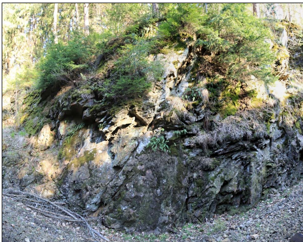
Obr. 178: detail stavu degradace levostranné části masívu v km 28,870, viditelné tektonické poruchy a rozpad podél ploch foliace
