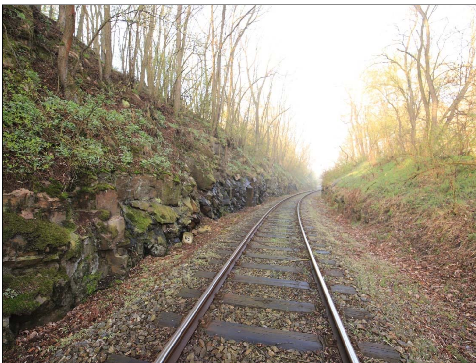
Obr. 05: celkový pohled na zářez směr Vimperk v km 4,300 – 4,350, pravostranný příkop je zcela zaplněný
