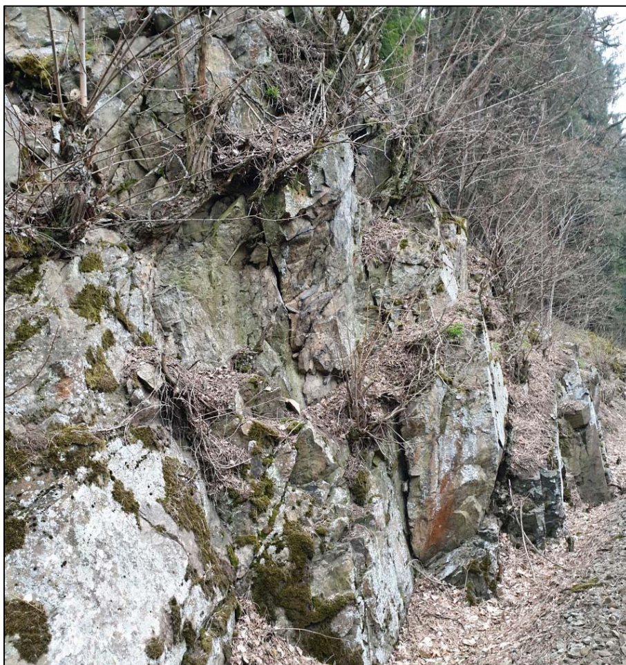
Obr. 214 a 215: detailní pohled na blokovou odlučnost a extrémní narušení masívu náletem v km 30,945 – 30,955, míra rozevření puklin 5 – 65 mm
