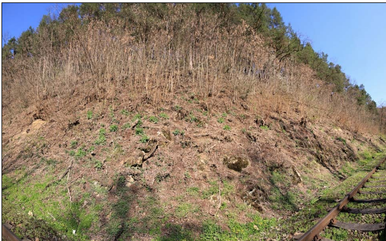
Obr. 157: panoramatický pohled na poloskalní svahy v km 25,050 - 25,090 , jen lokální výchozy zvětralého skalního podkladu, četné erozní narušení svahu
