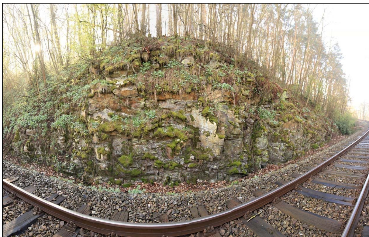
Obr. 26: panoramatický pohled na levostranný svah v km 4,455 – 4,480 Strmý svah, s horní hranou silně porostlou vegetací, horní partie silně degradované, blokový rozpad
