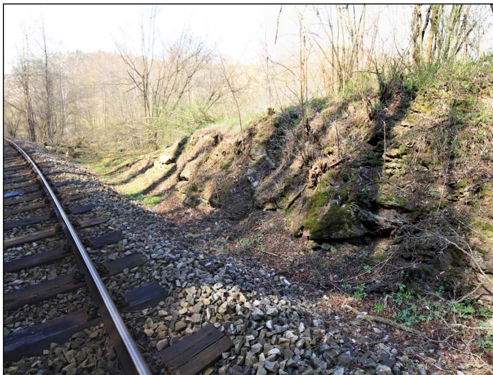
Obr. 51: pohled na závěrečnou část pravostranného svahu v km 15,325 – 15,330, souvislá degradace a velká míra zvětvání masívu po celé délce pravostranného svahu
