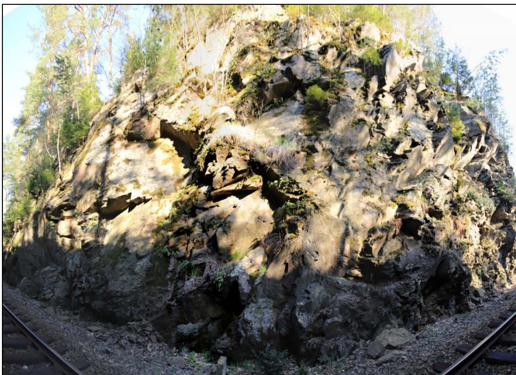
Obr. 187 a 188: panoramatické pohledy na levostranný skalní masív v km 28,890 – 28,910, výrazná členitost masívu s hustým vegetačním krytem v horních partiích svahu
