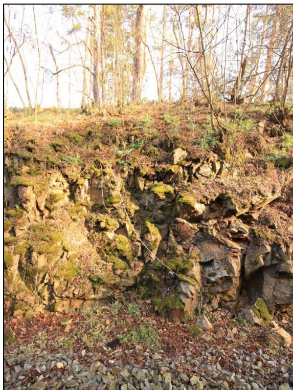
Obr. 19 a 20: detail degradace a rozpadu masívu pravostranného svahu v km 4,380 – 4,400
