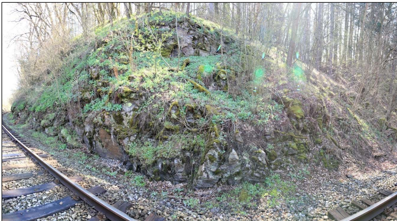
Obr. 55: panoramatický pohled na závěrečnou část masívu v lokalitě U Papírny, levá strana km 15,340 – 15,355, členitý svah s výrazným porušením vegetací a mrazovým zvětráváním
