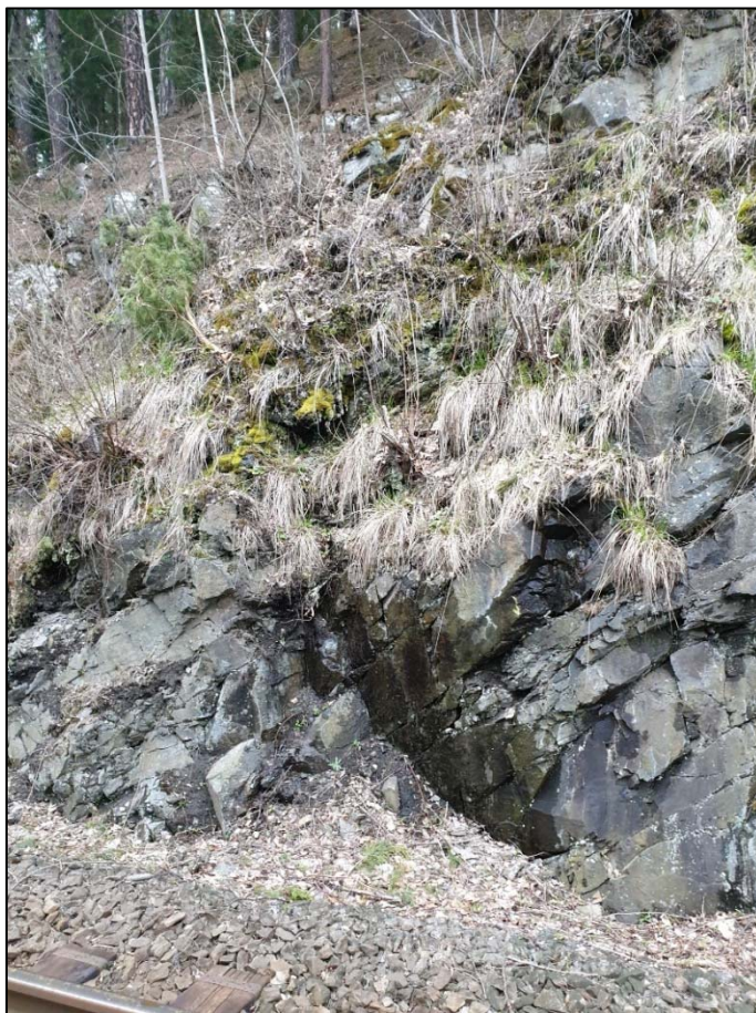
Obr. 211: detail stavu narušení masívu a propustnosti masívu v km 30,935
