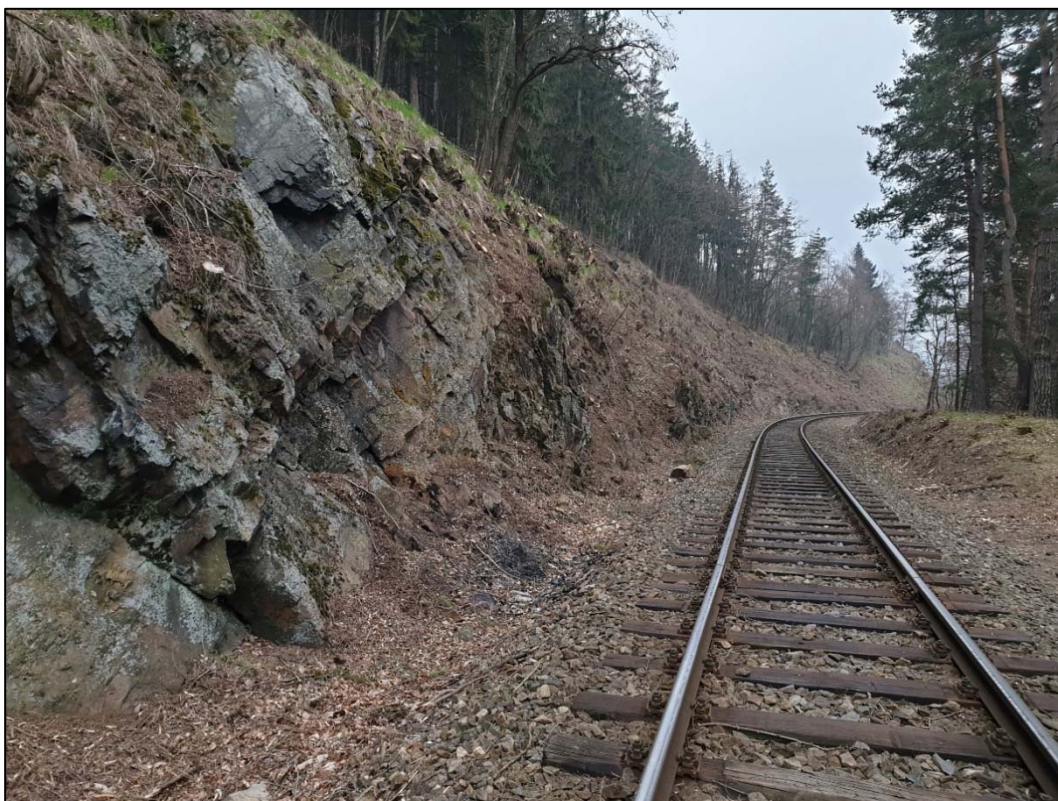
Obr. 236: pohled na skalní svah po odstranění vegetace v km 31,870 – 31,900, stálý charakter skalního svahu po celém úseku
