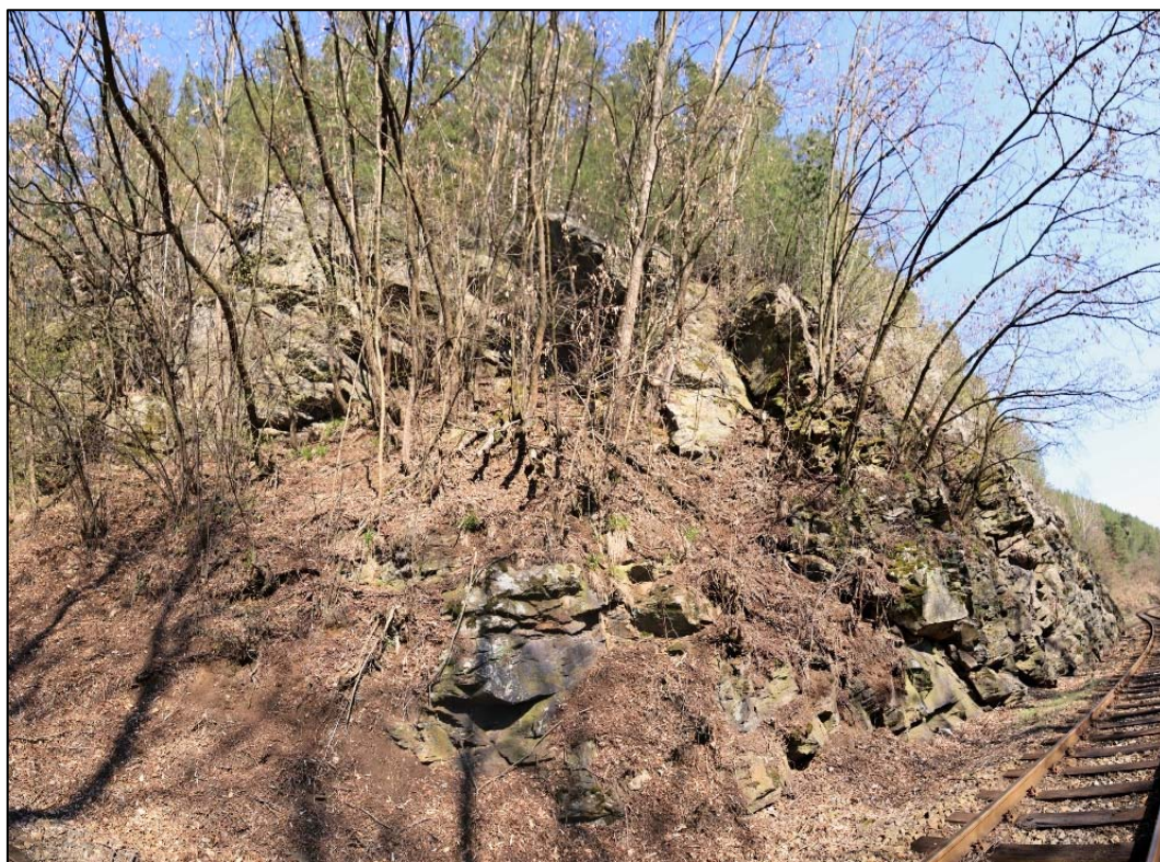
Obr. 130: panoramatický pohled na rizikovou partii masívu s blokovým opadem v km 24,750 – 24,760, kritický opad bloků z horních partií masívu s extrémně hustým porostem náletové vegetace
