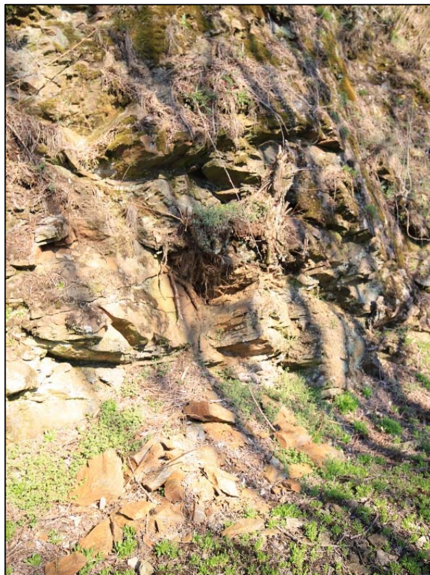
Obr. 151 a 152: detail stavu narušení a rozpadu masívu v km 24,990 – 24,995
