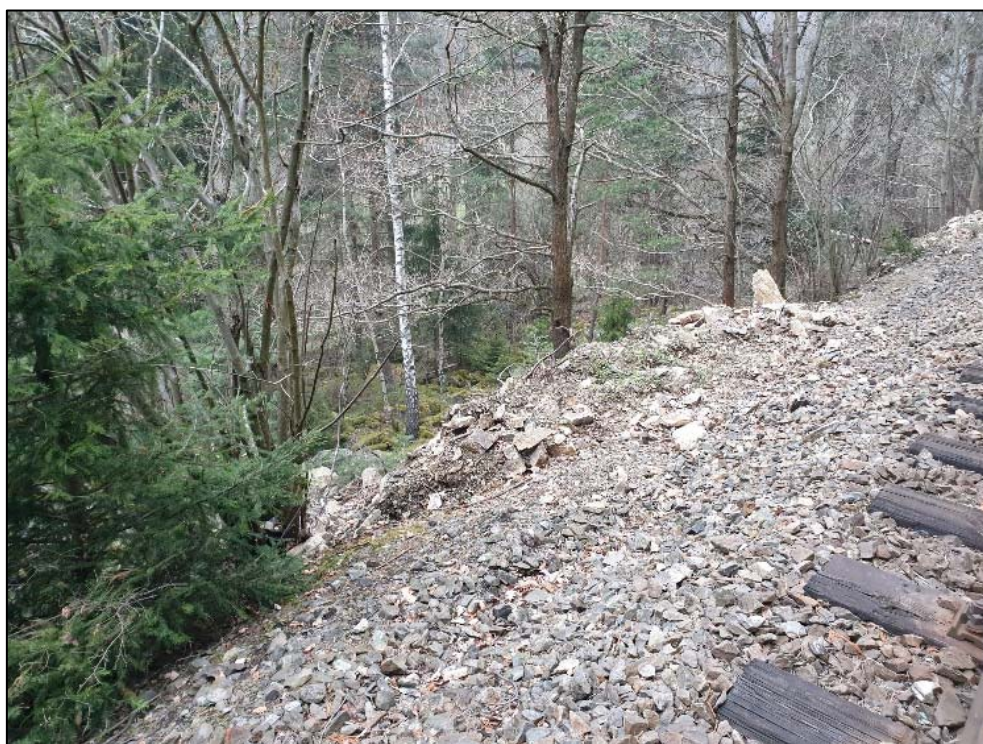
Obr. 203: pravostranný svah trati v km 30,430 – 30,440, kdy je zde ukládána suť z likvidovaných říčních bloků
