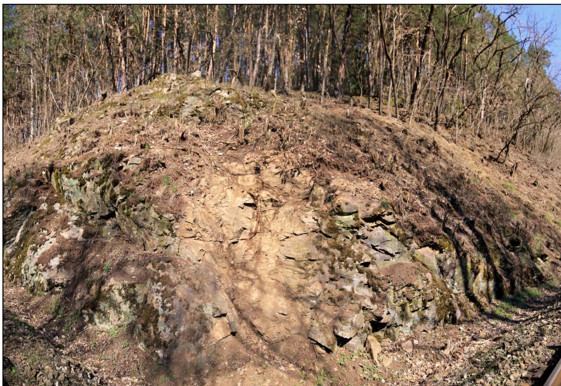
Obr. 149: panoramatický pohled poruchu skalního svahu s erozním rozpadem v km 24,960
