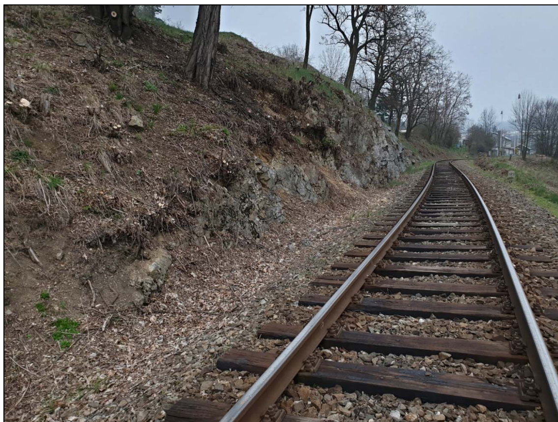
Obr. 254: pohled na míru zvětrání skalního svahu s extrém narušením kořenovým systémem vzrostlých stromů a rozpadem horniny na jemnozrnnou frakci
