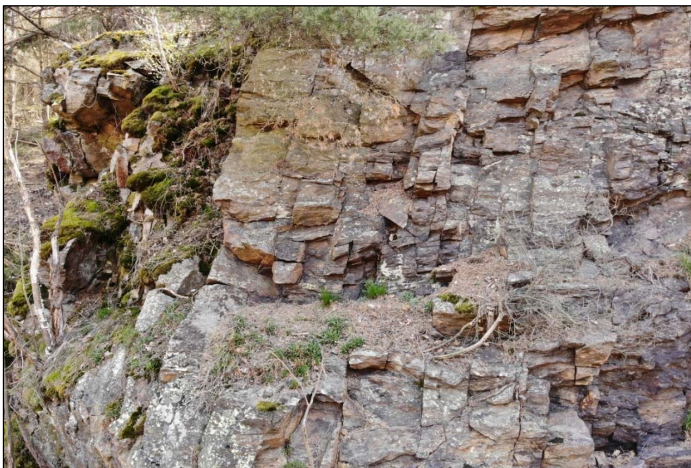
Obr. 63: detail stavu horní partie skalního masívu v km 15,360 – 13,365, patrné lokální výrazné poruchy, vlevo na snímku
