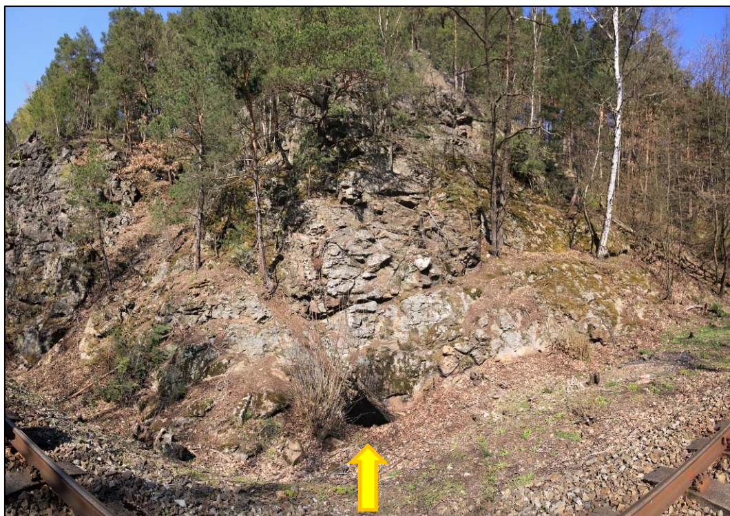
Obr. 143: panoramatický pohled na skalní svahy v km 24,820 – 24,840 s vyznačenou polohou nezajištěného vstupu do staré štoly, evidováno jako jeskyně, během stavby musí být chráněno proti poškození
