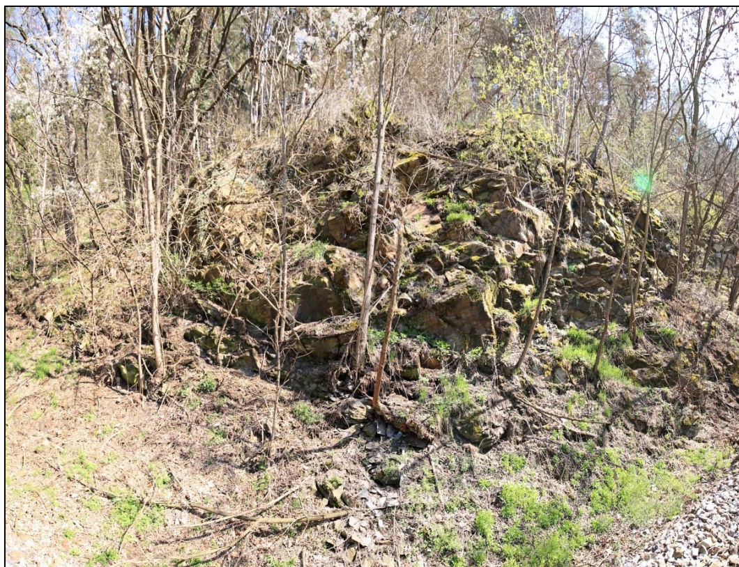
Obr. 102: exogenními činiteli a zvláště vegetací narušený skalní masív v km 19,165 – 19,180
