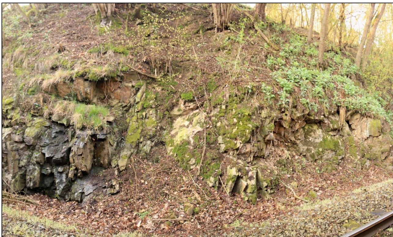
Obr. 15: panoramatický pohled na levostranný svah v km 4,380 – 4,400, Silná degradace a zvětrání masívu a erozní splachování do příkopu
