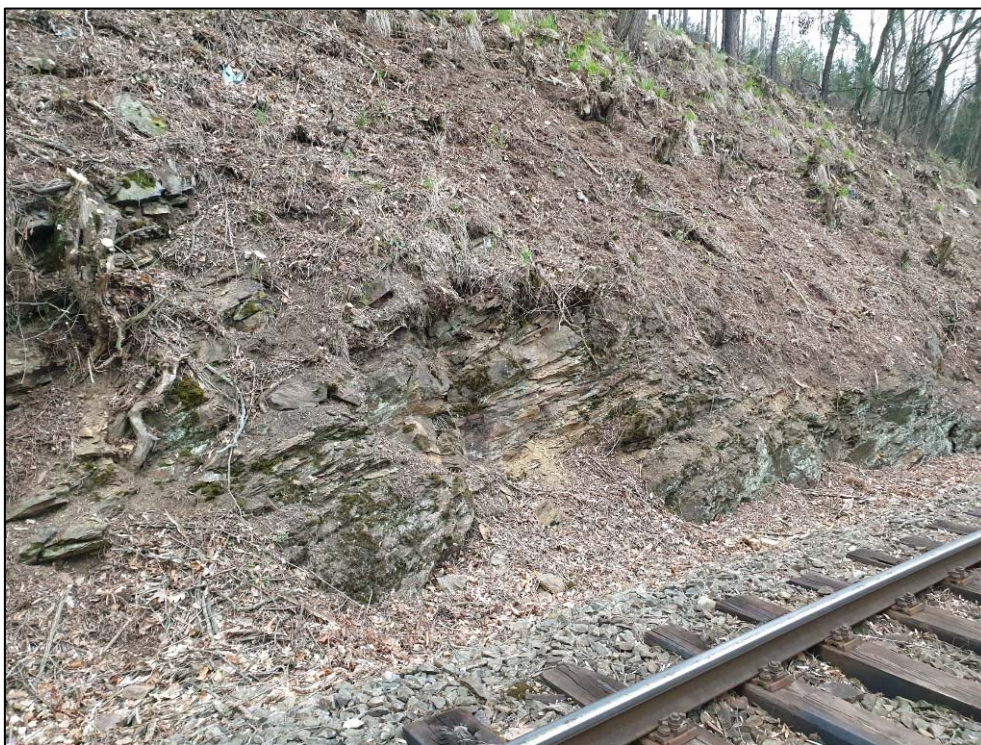
Obr. 245: střípkovitý rozpad zcela zvětralé horniny v km 31,960
