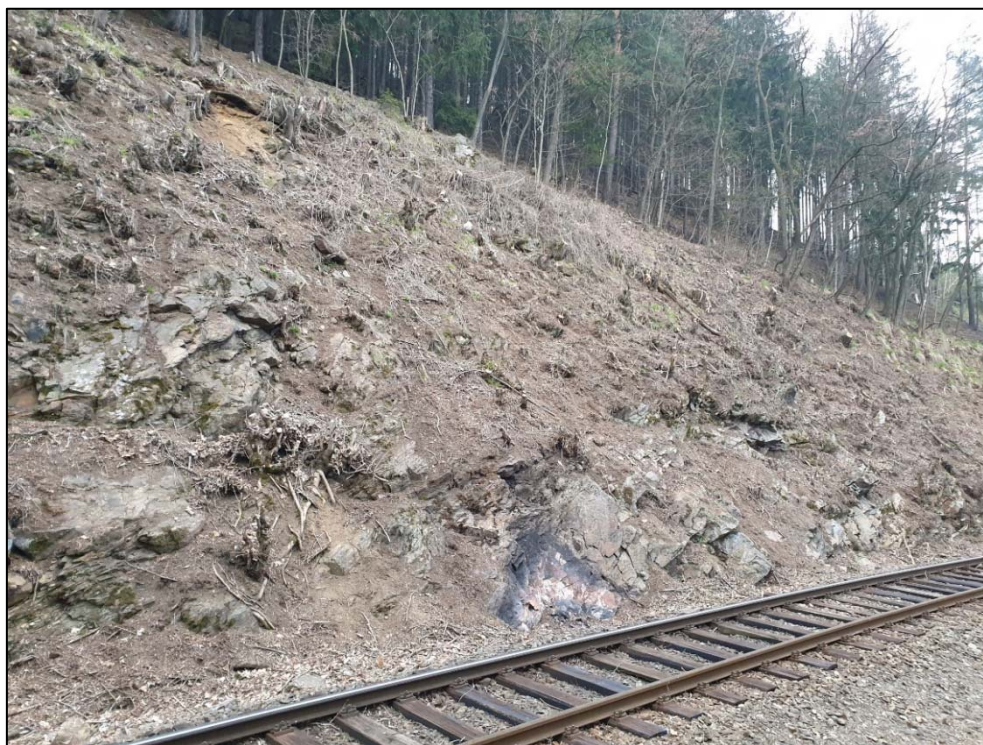
Obr. 243: skalní svah v km 31,955 – 31,980 s povrchovým značným zvětráním po celém rozsahu skalního svahu
