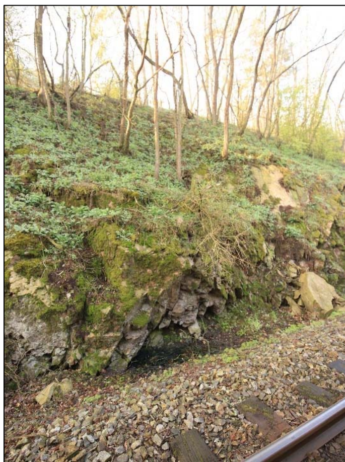
Obr. 16: stav postupného rozpadu zvětralého masívu v km 4,400 – 4,420
