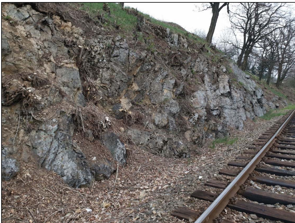
Obr. 257: narušení a rozpad skalního svahu v km 32,200 – 32,230
