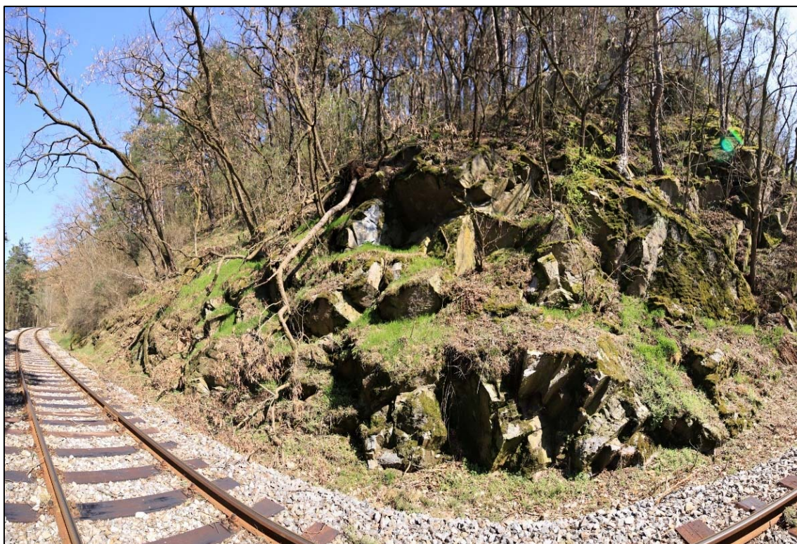
Obr. 116: panoramatický pohled na výrazný skalní masív v km 19,375 – 19,385 s blokovou odlučností a velmi hustým porostem vegetace a stromů, viditelný velmi výrazný systém ploch odlučnosti masívu, který přímo vymezuje rozsah a způsob rozpadu masívu
