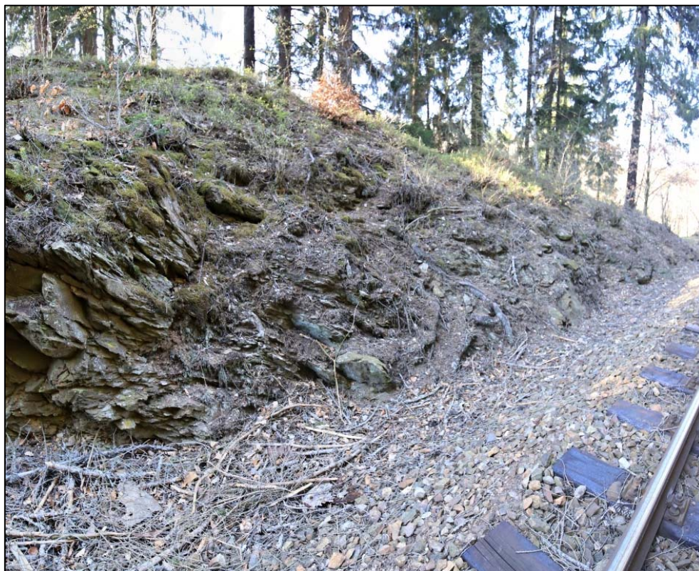
Obr. 176: pohled na pravostrannou část zářezu v km 28,850 – 28,860, znatelné extrémní zvětrání masívu na dílčí fragmenty
