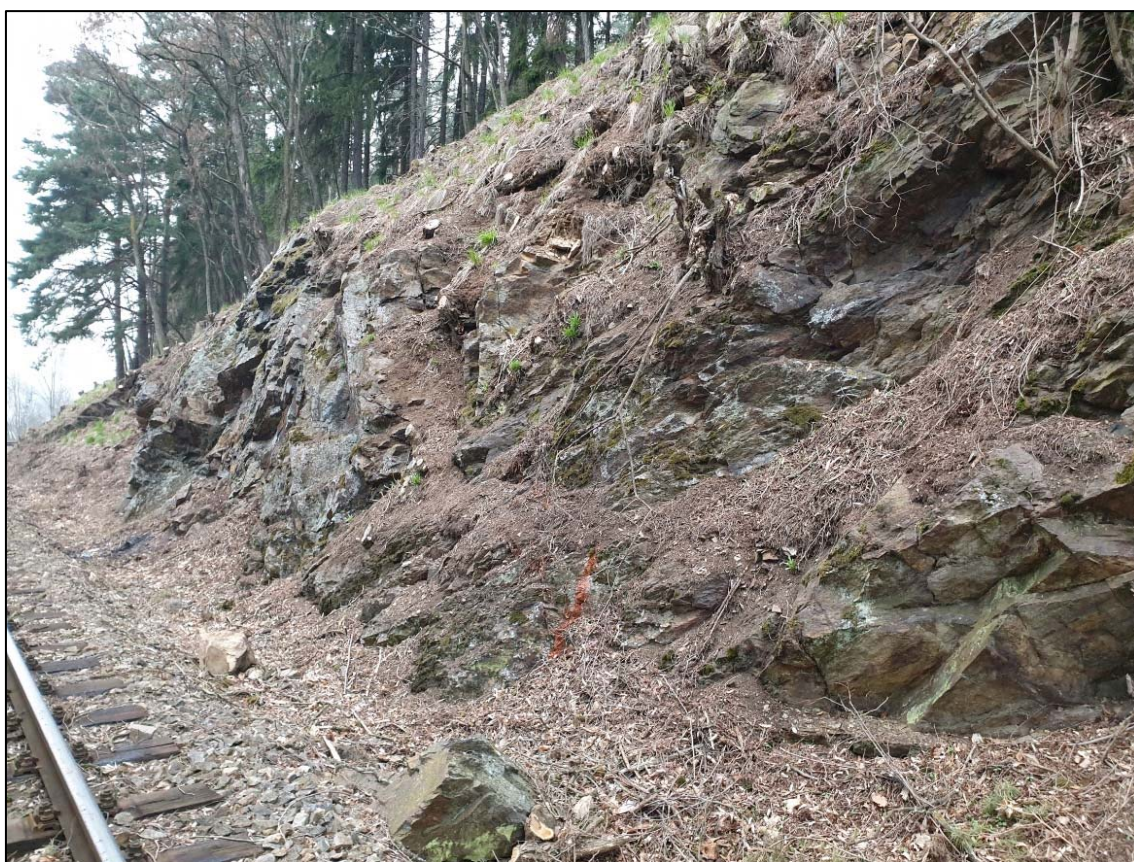
Obr. 239: detail kritického profilu svahu v km 31,876 s projevem opadu a řícení bloků ze skalního svahu
