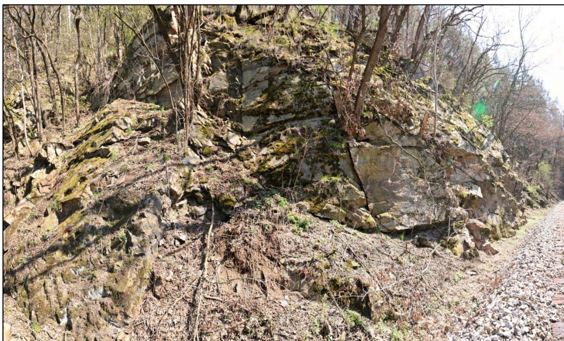
Obr. 106: panoramatický pohled na narušený skalní masív v km 19,175 – 19,195
