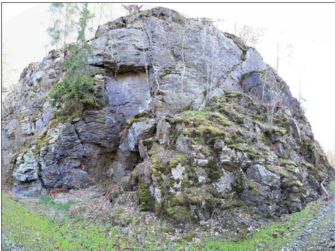
Obr. 61: panoramatický pohled hlavní defilé skalní stěny v km 15,460 – 15,495, v puklinách hustá náletová vegetace, stěna však bez většího narušení zvětráním či plochami odlučnosti
