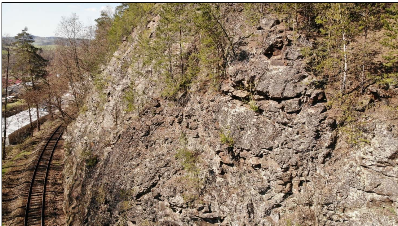
Obr. 135: pohled na celé defilé skalní stěny a jeho horních partií s četným porostem náletové vegetace, horní část svahu je mimo pozemky SŽDC, s.o. pohled směr Strakonice, trať v úseku km 24,770 – 24,800
