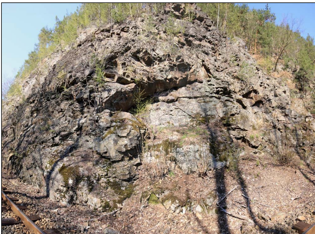
Obr. 141: panoramatický pohled na členité skalní defilé v km 24,795 – 24,815, četné převisy ve skalním masívu
