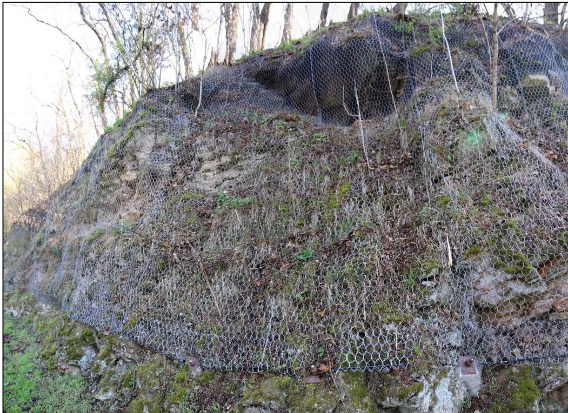
Obr. 38: celkový pohled na stav svahu se zajištěním sítěmi a v horních partiích podložených polymerovými geomatracemi, km 12,340 – 12,355
