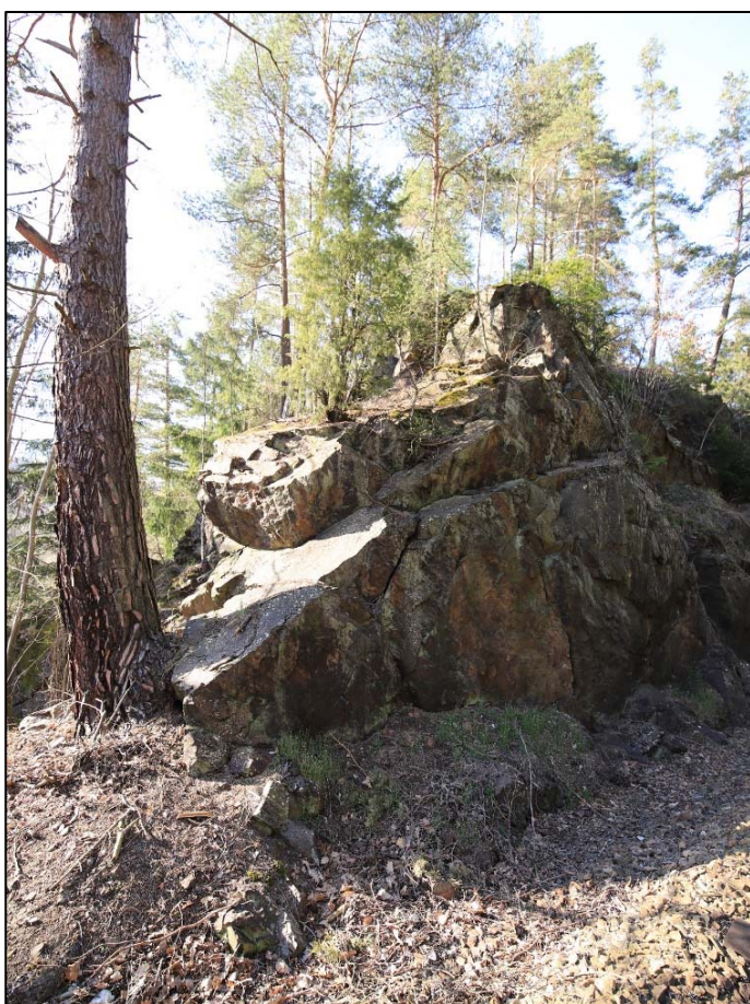
Obr. 193, 194 a 195: pravostranný závěr zářezu km 28,915 – 28,925 blokový rozpad masívu s přispěním pákového namáhání masívu vzrostlou borovicí a souvisejícím mrazovým namáháním v puklinách
