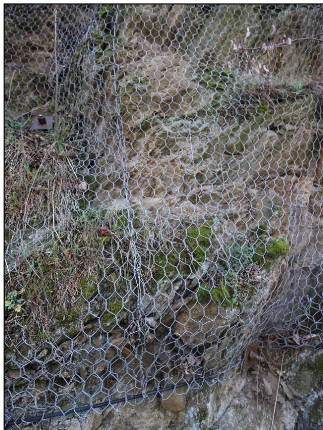
Obr. 36 a 37: detail degradace masívu a namáhání sítě po výšce svahu, kapacita sítě je z 90% vyčerpána
