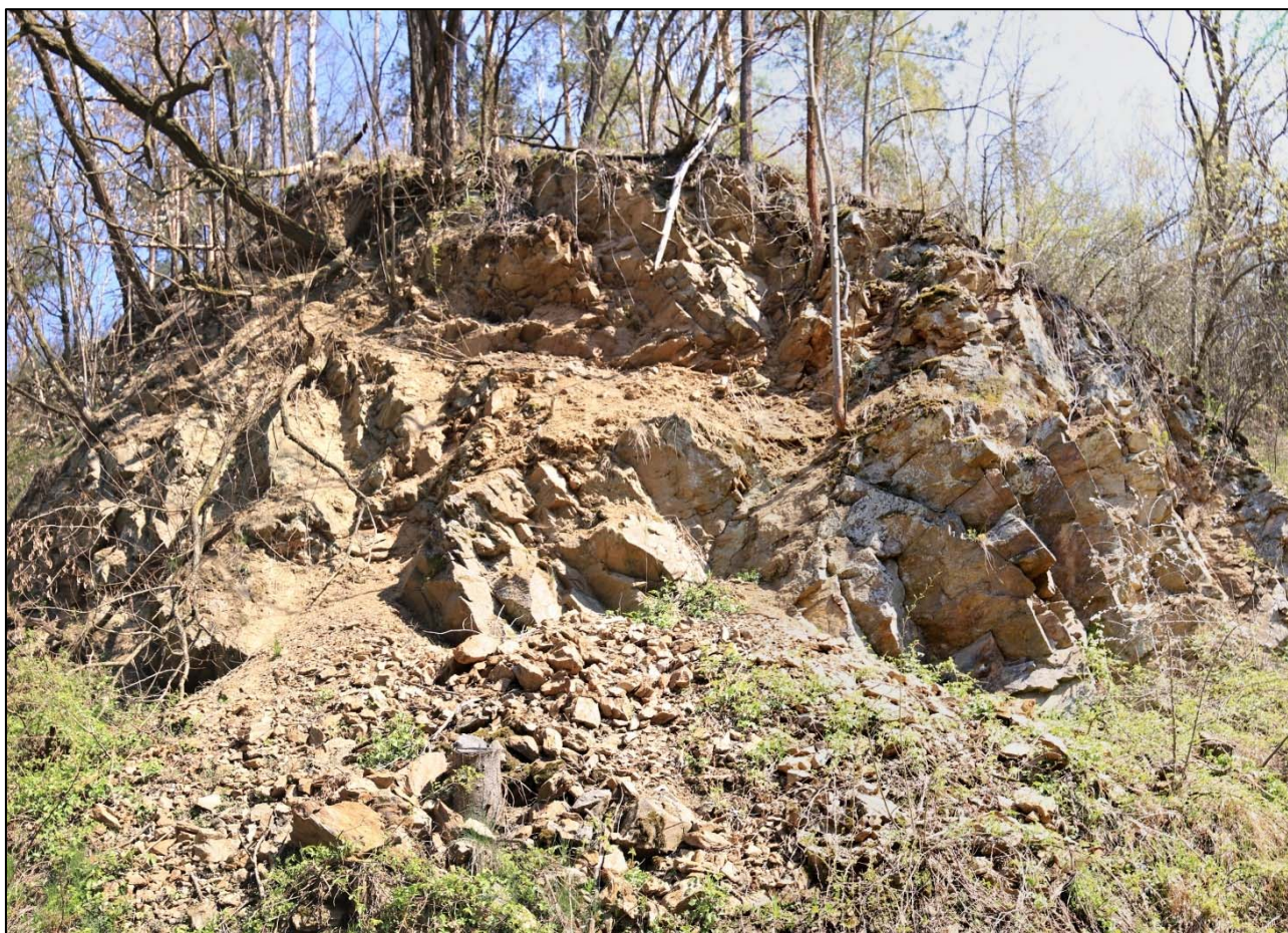
Obr. 80: spodní pohled na kritickou polohu s masivním opadem v km 16,135 – 16,145, horní partie silně narušeny stromy
