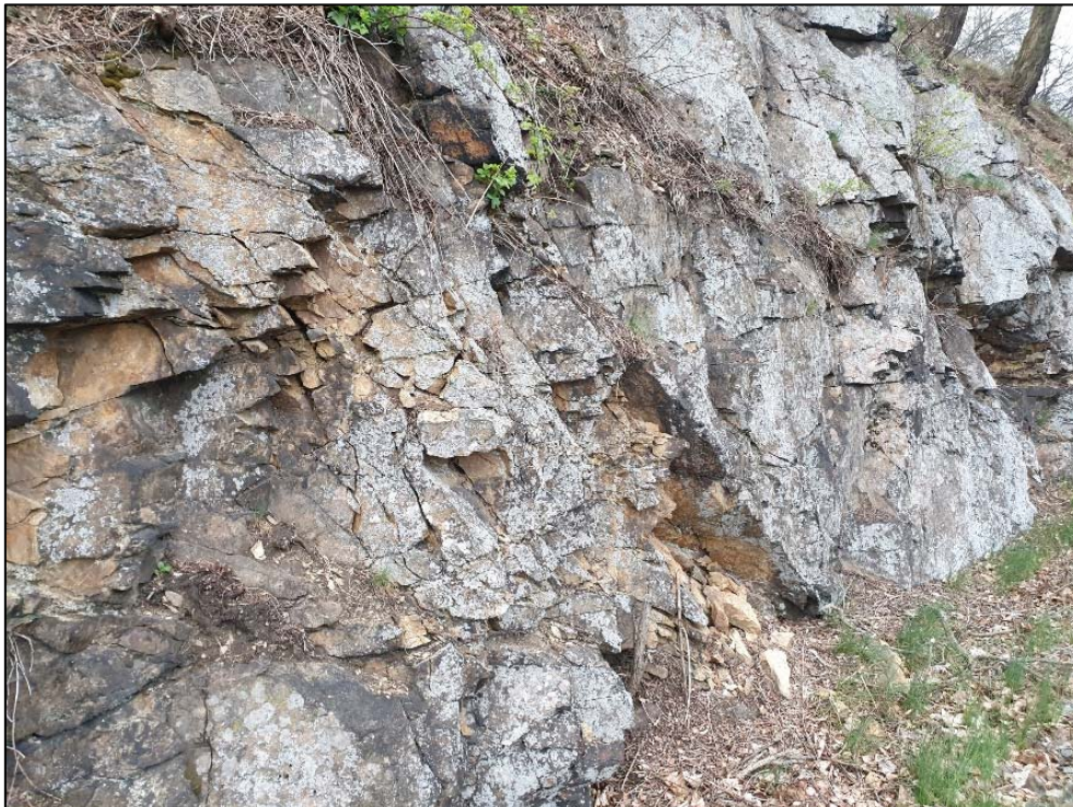
Obr. 258: detail fragmentace a rozpadu masívu v km 32,210
