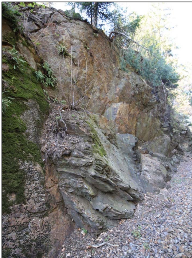
Obr. 185 a 186: pravostranná část zářezu v km 28,885 s výraznými převisy v horní partii a blokovým posunem ve výšce cca 4,5 m nad TK, systém ploch odlučnosti značně vymezuje stavbu uměle vytvořeného zářezu
