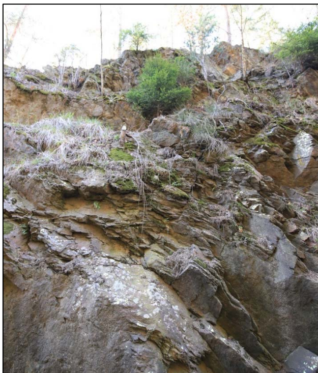
Obr. 191: pohled na členitost a míro degradace pravostranného svahu zářezu v km 28,905
