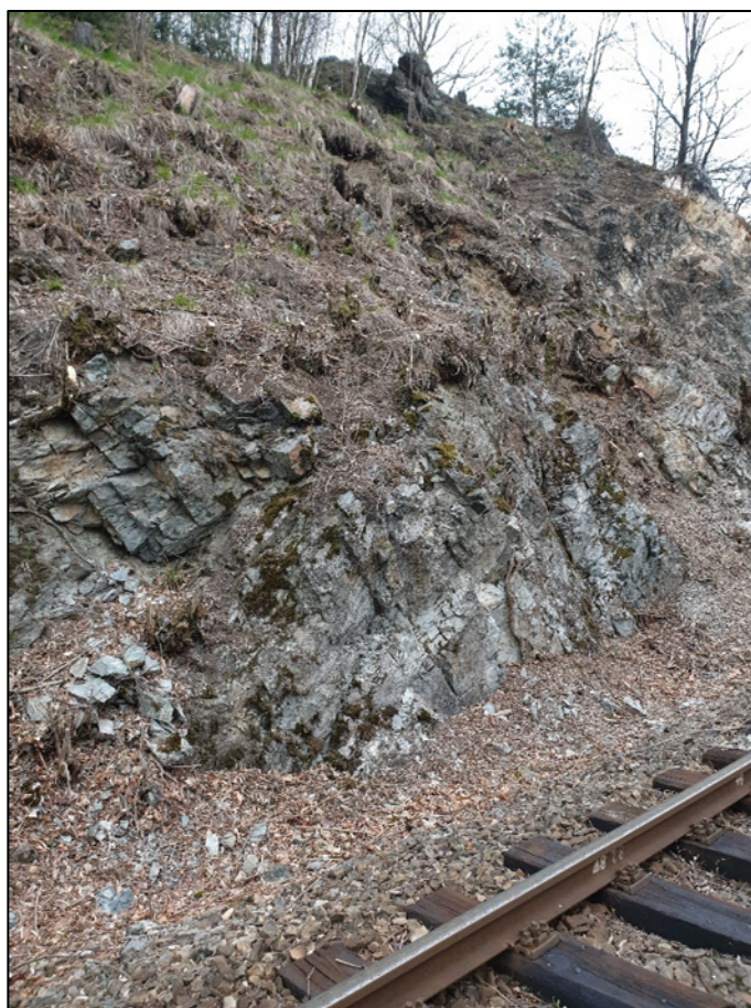
Obr. 248: detail míry zvětrání masívu v km 32,055
