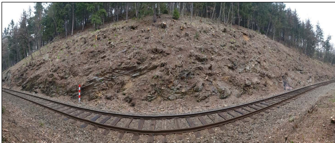
Obr. 241: panoramatický pohled na skalní svah v úseku 31,890- 31,950 s poruchovými zónami a četnými polohami opadu do prostoru trati
