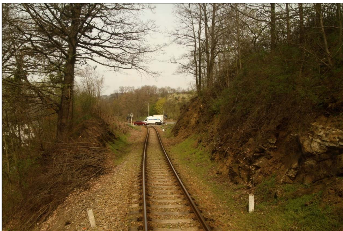
Obr. 42: Celkový pohled na stav zářezu v km 13,525 – 13,550, směr Strakonice, Hustý vegetační porost svahu a zcela zanesený podélný příkop
