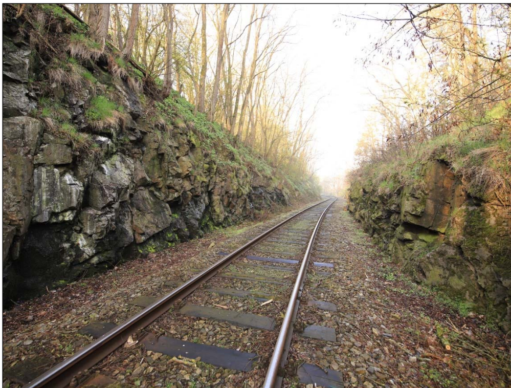
Obr. 10: celkový pohled na zářez v km 4,360 – 4,390, členitost skalního svahu, hustota porostu svahu stromy
