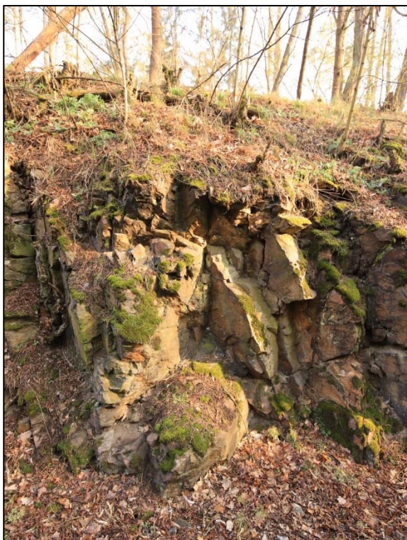
Obr. 17 a 18: detail degradace a rozpadu masívu pravostranného svahu v km 4,360 – 4,380
