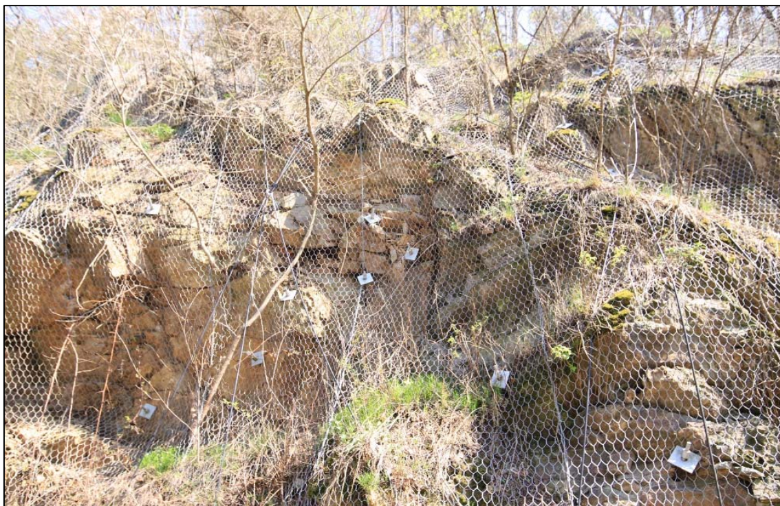
Obr. 92: pohled na zachycené části masívu v sítích a extrémní narušení svahu s rozevřením většiny puklin nad 15 mm
