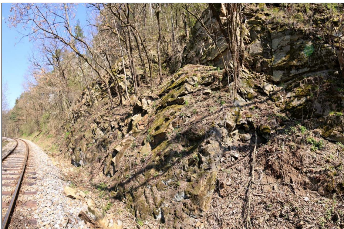
Obr. 107: celkový pohled na havarijní skalní masív s projevy opadu bloků do bezpečného vyhrazeného prostoru trati v km 19,175 – 19,195
