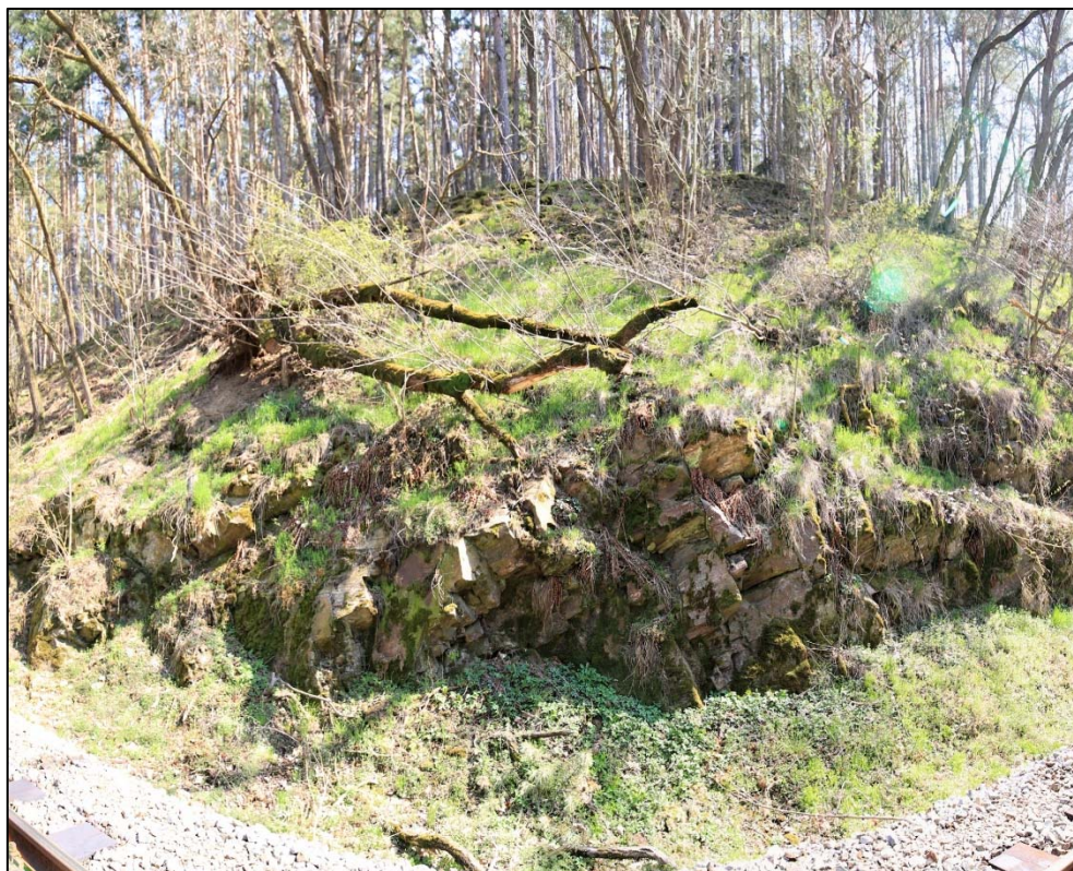
Obr. 84: stav aktuálního zvětrání v km 18,880 – 18,890 vlevo, stav zanesení příkopu
