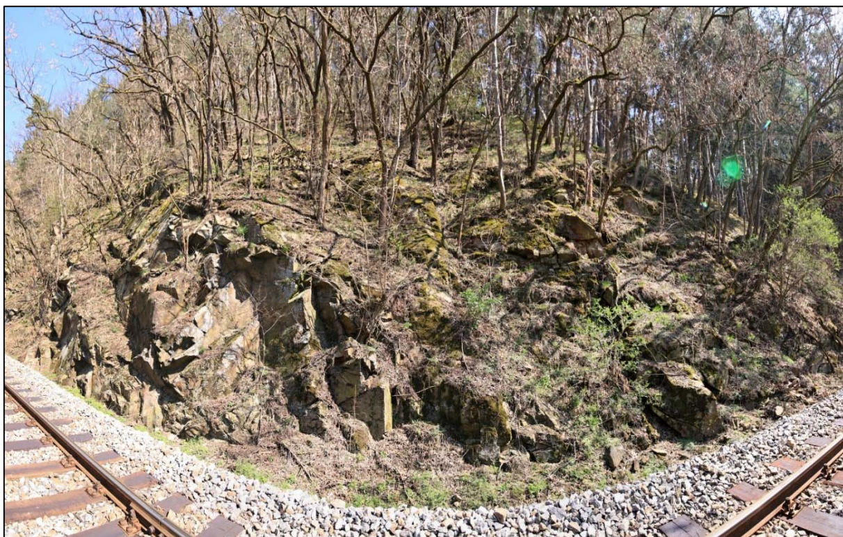
Obr. 110: panoramatický pohled na havarijně narušený skalní masív v km 19,195 – 19,225, vpravo viditelné skalní ploužení rozpadlých bloků
