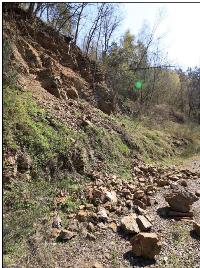
Obr. 74: projev řízení degradovaného masívu do prostoru paty svahu a drážního tělesa, část bloků ukončila svůj pohyb až na kolejovém svršku
