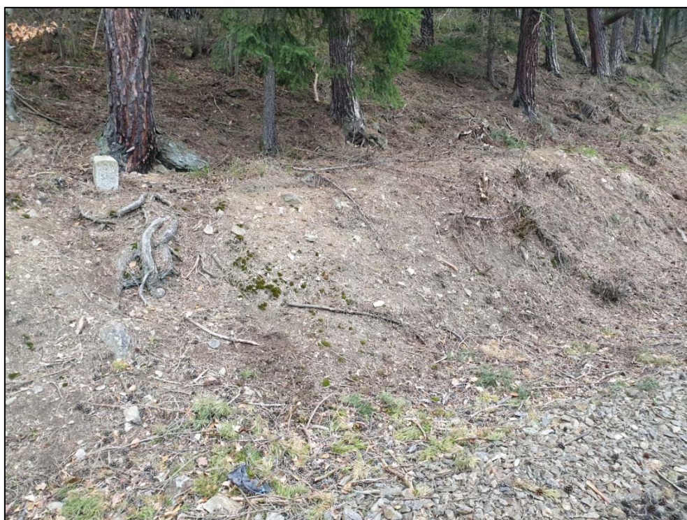
Obr. 229: levostranná část svahu se zaneseným podélným příkopem v úseku km 31,780 – 31,800
