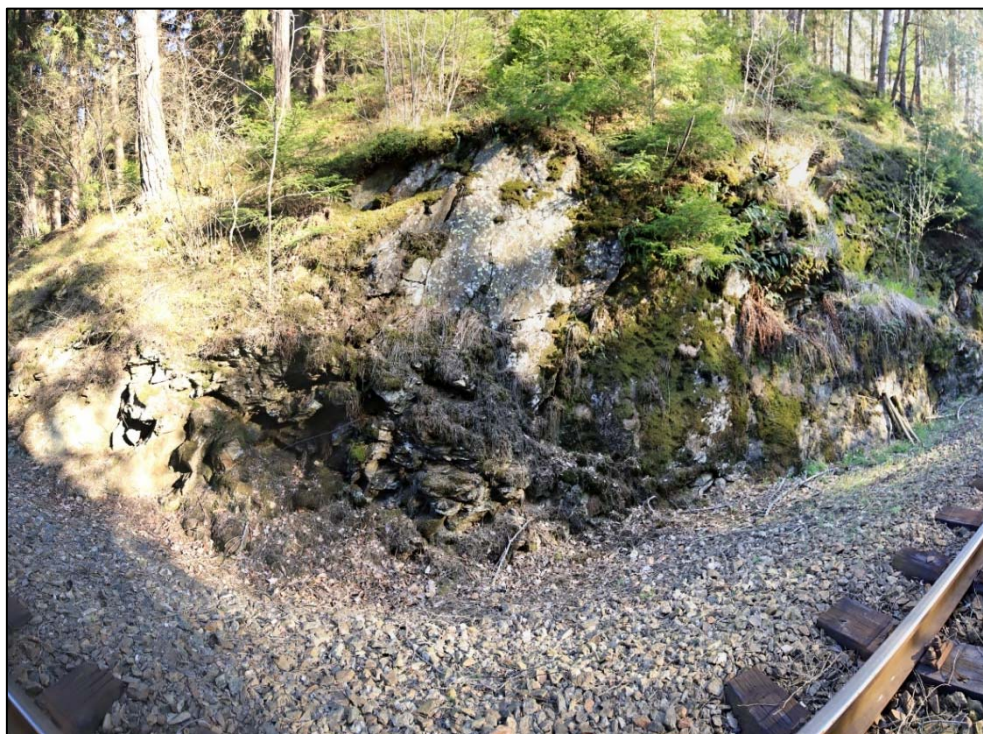
Obr. 175: pohled na levostrannou část skalního zářezu v km 28,850 – 28,860, s hutným vegetačním pokryvem
