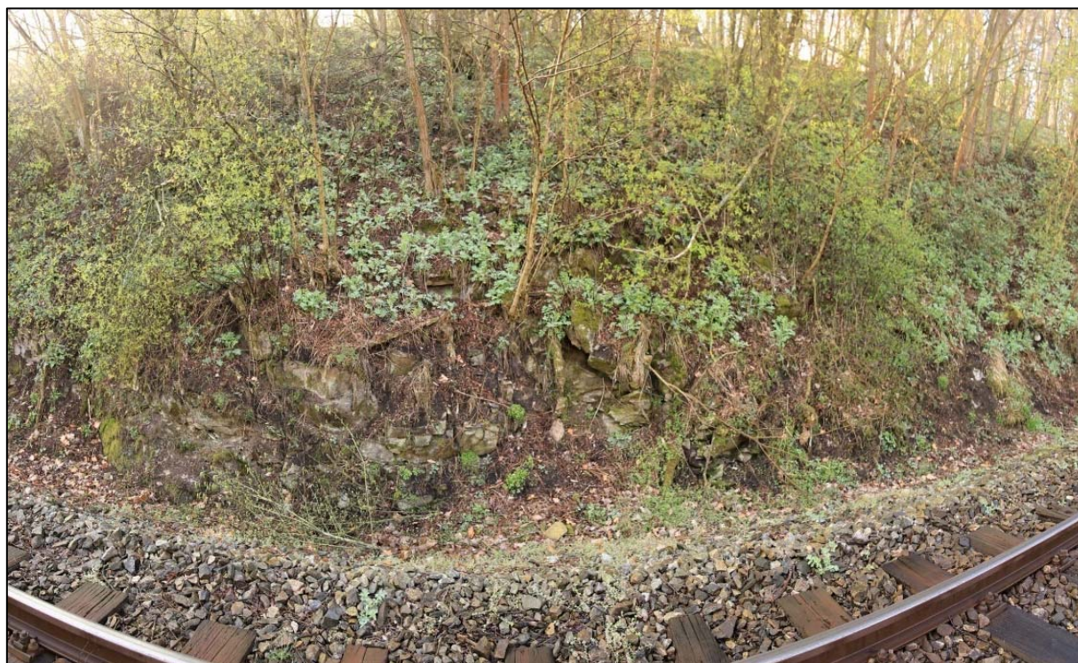
Obr. 25: panoramatický pohled na levostranný svah v km 4,430 – 4,440, Velmi hustý vegetační porost a velká degradace masívu s odloučenými bloky
