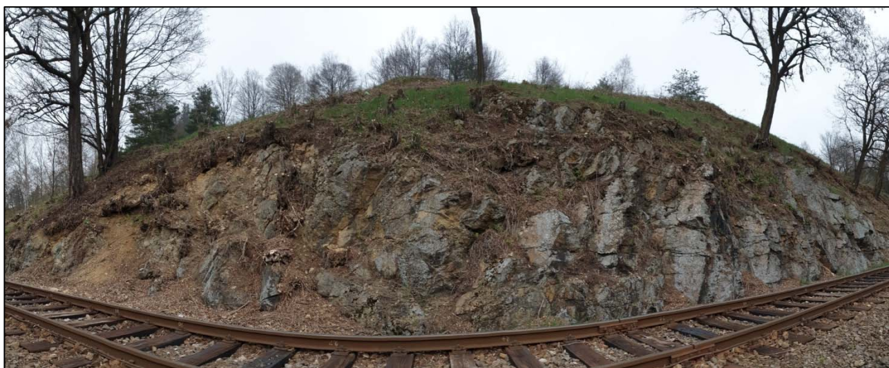
Obr. 255: panoramatický pohled na hlavní část skalního odřezu v km 32,180 – 32,220, znatelné známky značné míry zvětrání skalního svahu a erozní činnosti vody na skalní svah
