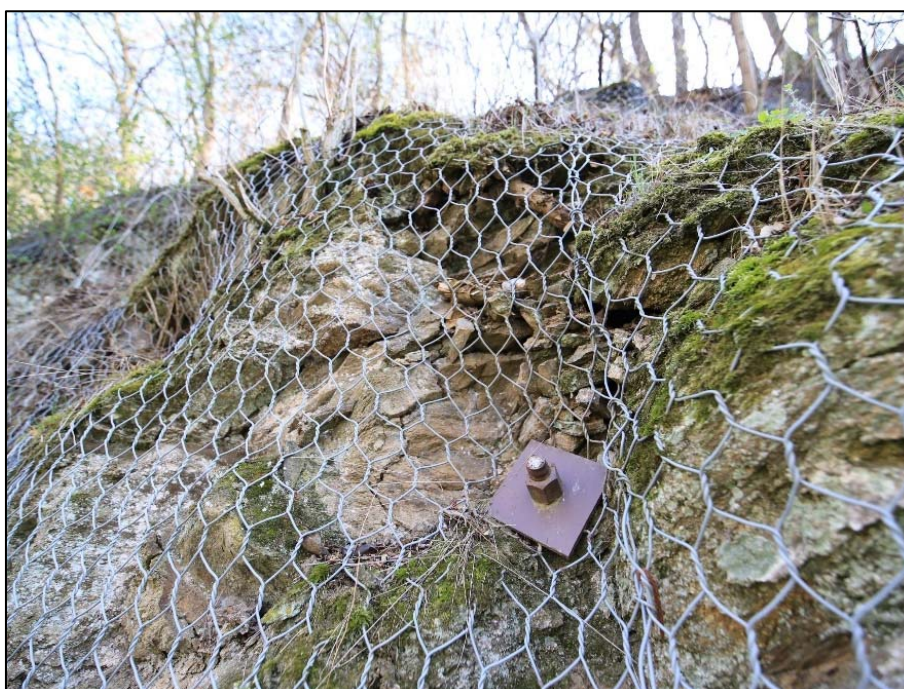
Obr. 35: detail degradace masívu a namáhání sítí u kotveního prvku
