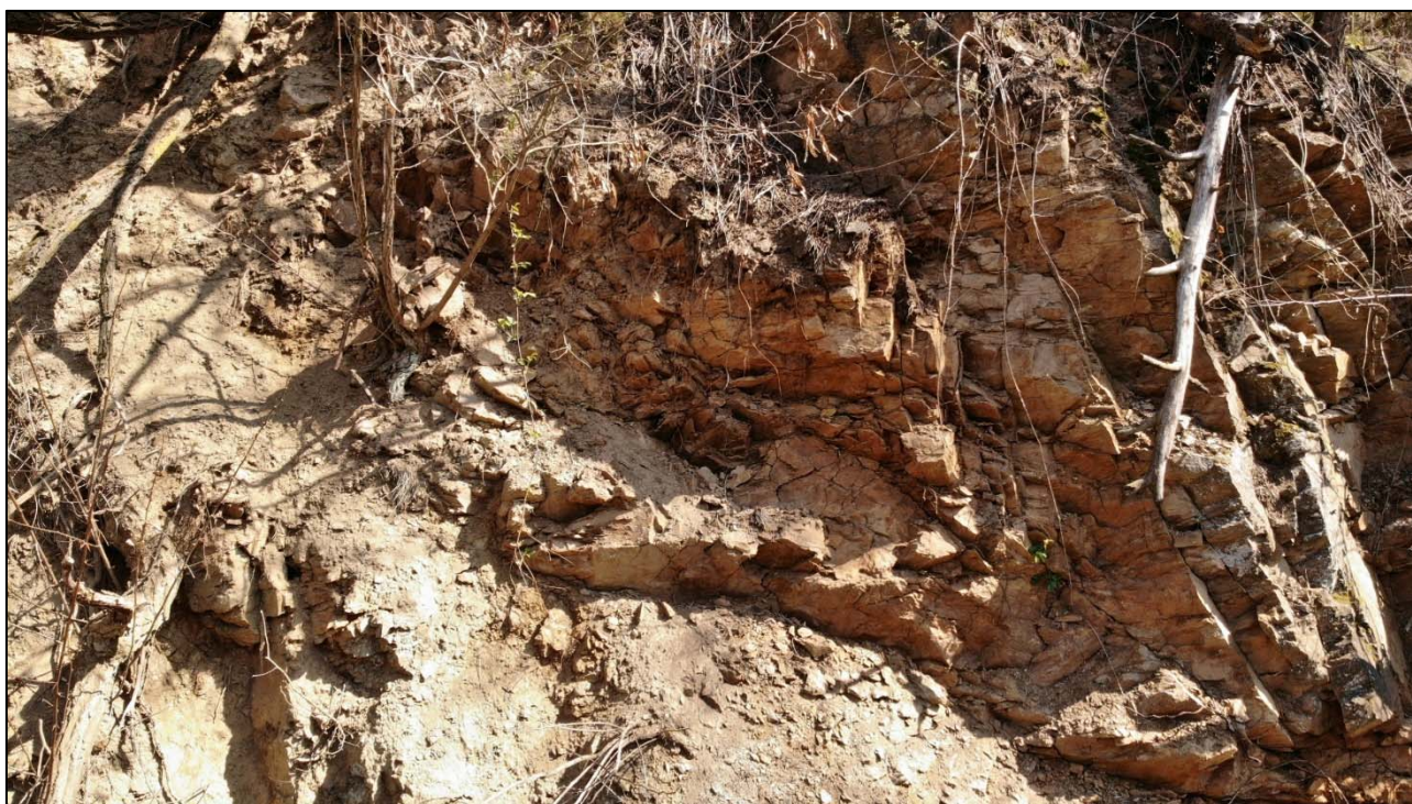
Obr. 77: detail degradace střední partie masívu, rozpad na dílčí fragmenty frakce 0,2 mm – 550 mm, rozevření puklin 10 – 65 mm
