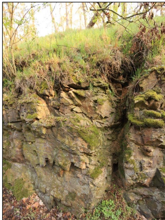
Obr. 13 a 14: detail silně degradovaných místa pravostranného svahu zářezu v km 4,340 – 4,350
