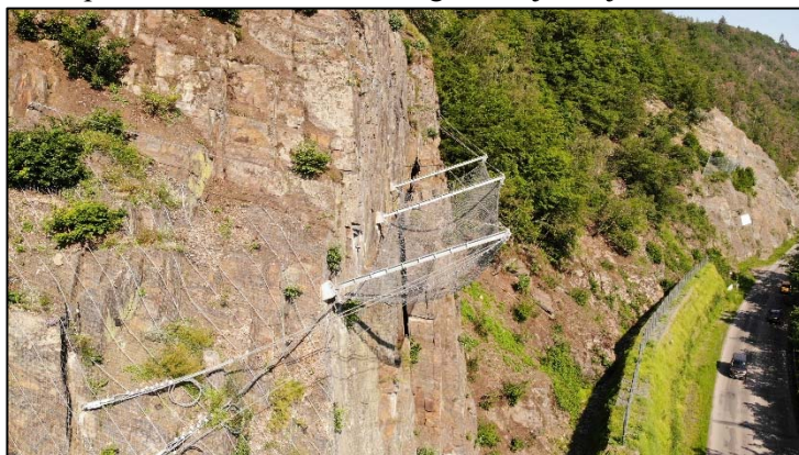
Obr. 7: Příklad provedení ochranné dynamické bariéry ve strmé stěně s úklonem 10° od vodorovné, instalace na skalním masívu u Štěchovic nad silnicí II/102
