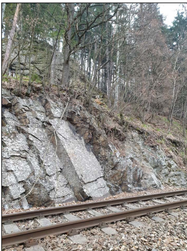
Obr. 223 a 224: dílčí pohledy na nejvíce narušené partie svahu v km 31,400 a 31,405 s vazbou na horní skalní bloky
