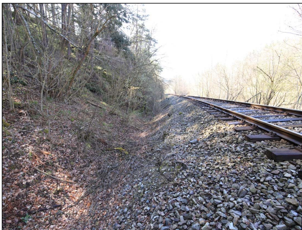
Obr. 57: stav příkopu v levé straně trati v km 15,360 – 15,380, ve svahu tělesa se nacházejí sítě ČD Telematika a zab. zař.
