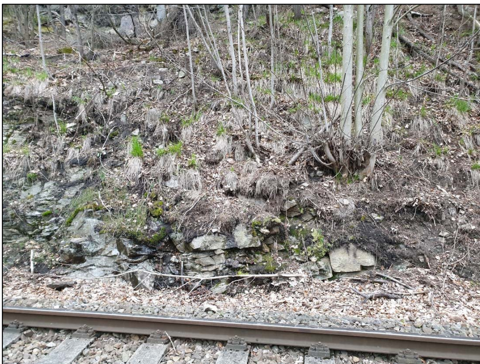
Obr. 226: detail míra zvětrání masívu v km 31,410 vlivem erozní činnosti vody a vegetace
