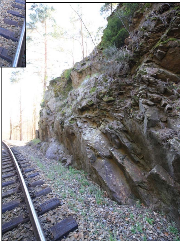
Obr. 189 a 190: pohledy na stavbu pravostranné části zářezu v km 28,890 – 28,820, proměnlivý sklon ploch odlučnosti a převážně tvorba převisů na horní partii svahu
