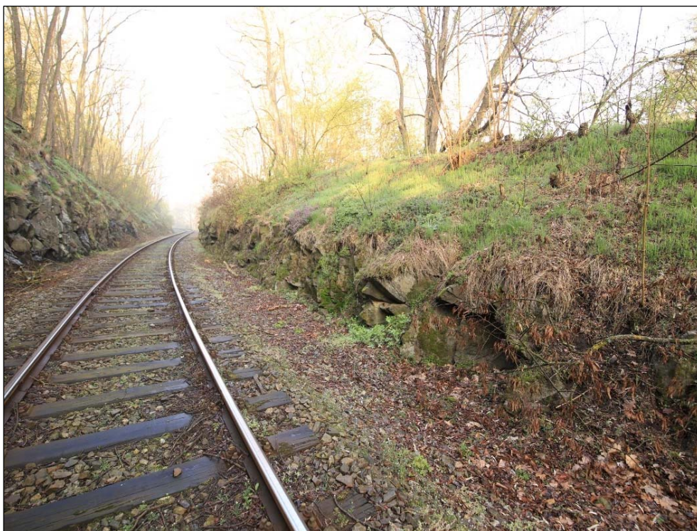
Obr. 08: stavba a míra zvětrání pravostranného svahu v km 4,310 – 4,350, míra vegetačního krytu a zaplnění podélného příkopu
