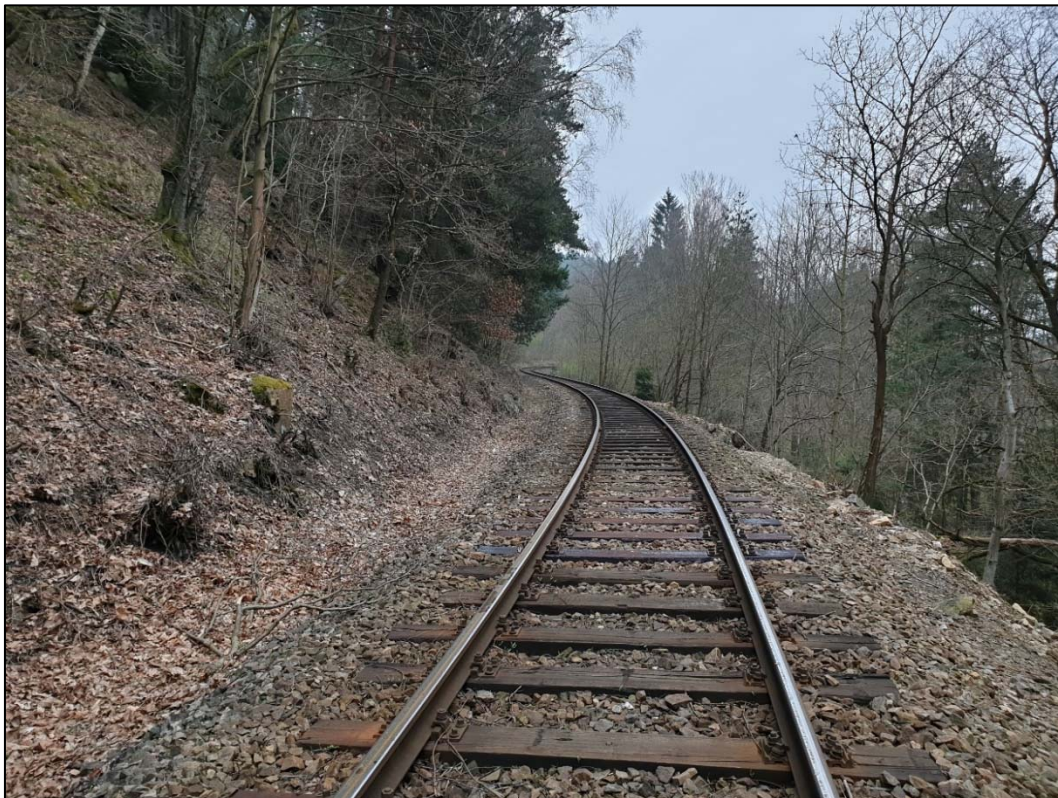
Obr. 198: pohled na začátek úseku objektu v km 30,380 směr Vimperk, vpravo na svahu patrné známky četné likvidace opadů bloků do prostoru trati z levostranného svahu
