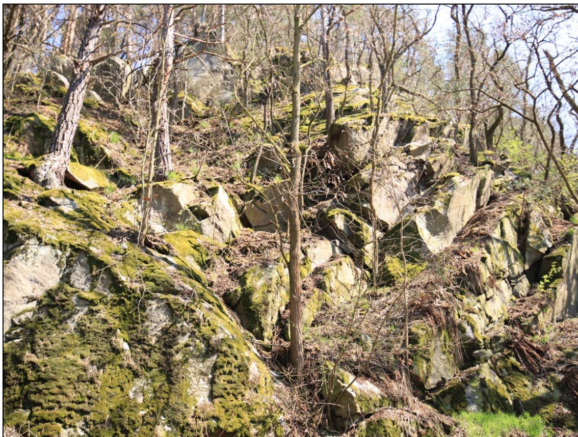
Obr. 118: pohled na kritický profil masivu v km 19,396 s viditelným rozpadem masivu a výrazným systémem ploch odlučnosti
