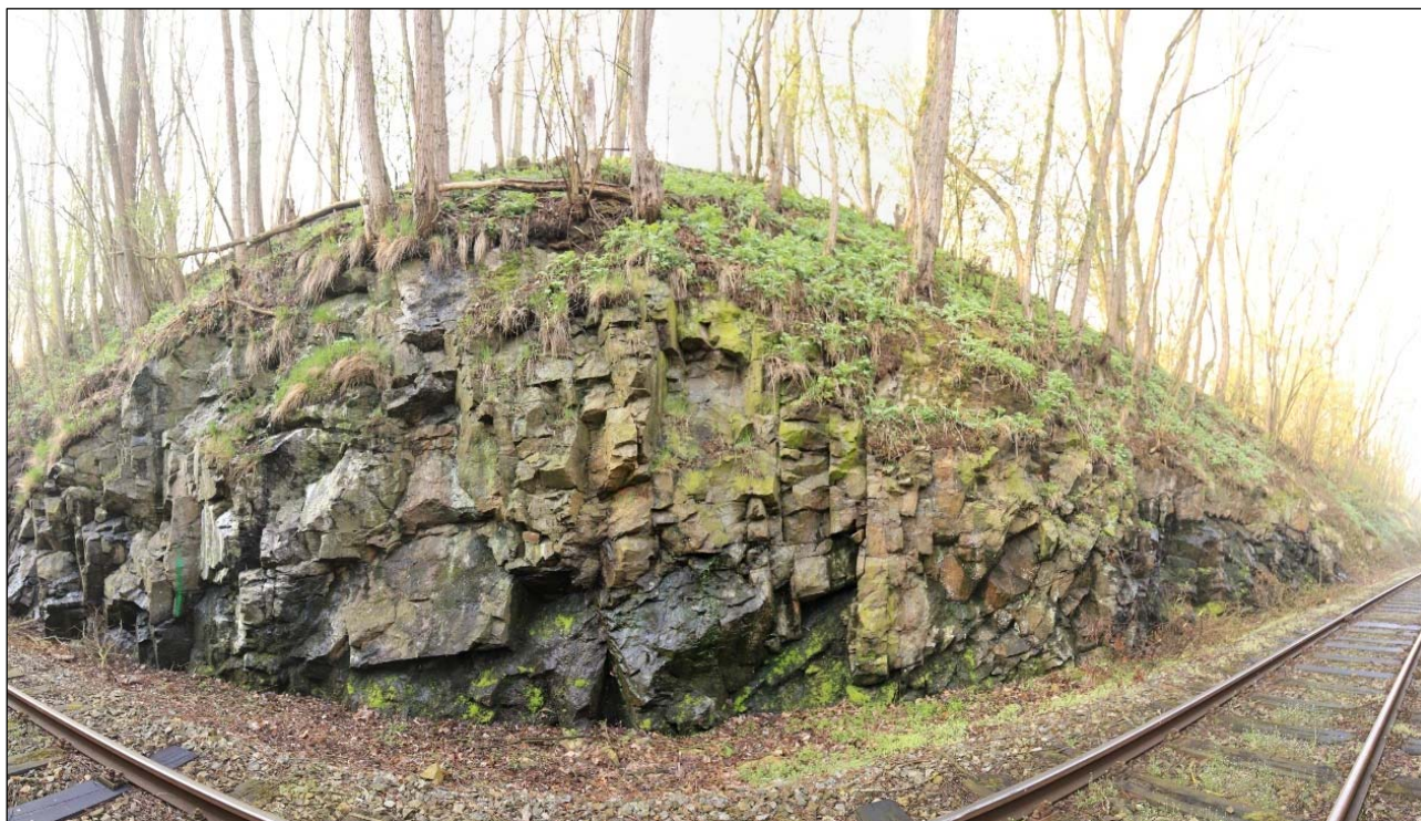
Obr. 11: panoramatický pohled na levostranný svah v km 4,355 – 4,380, blízkost vzrostlých stromů hraně svahu, a výrazné porušení masívu
