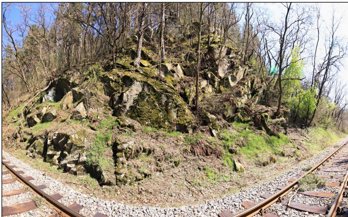
Obr. 117: panoramatický pohled na hlavní skalní defilé masívu v km 19,380 – 19,400, vyšší partie svahu jsou již na cizích pozemcích, vzrostlé stromy silně narušují masív, blokový rozpad bloků s řícením do prostoru trati, míra dokumentovaného rozevření puklin 10 – 55 mm
